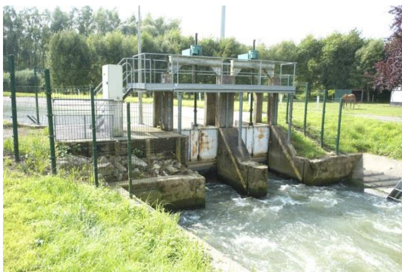
Vue aval du partiteur de Watten
