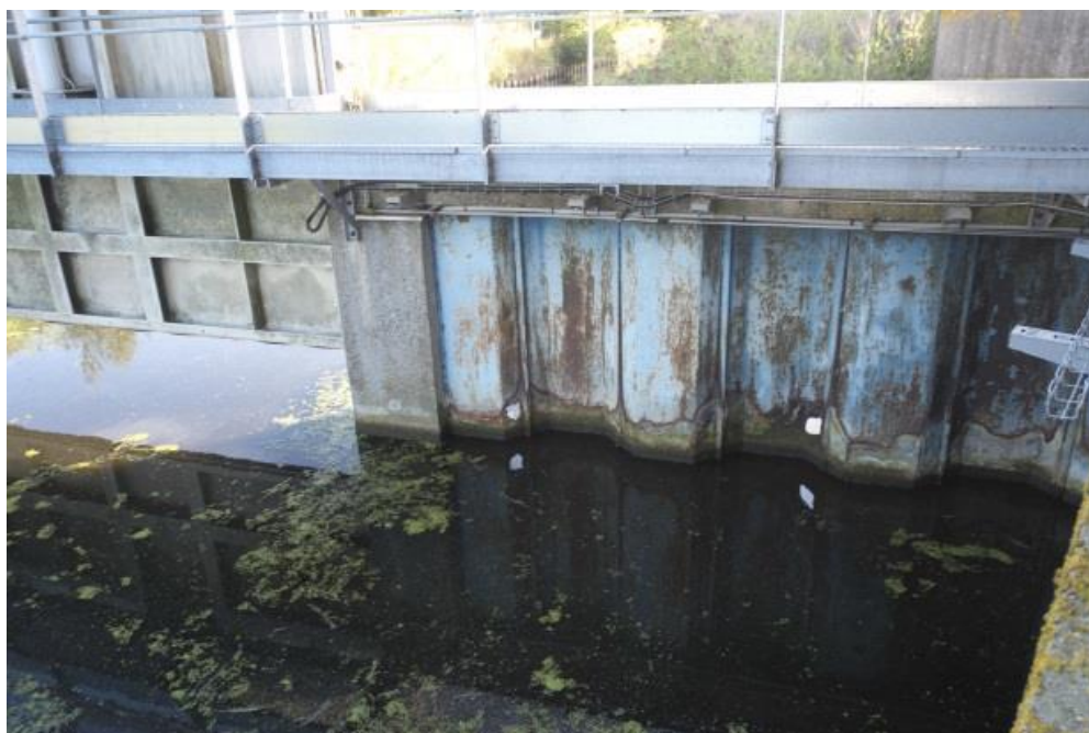
Station du Langhegracht : perforation du rideau de palplanche
