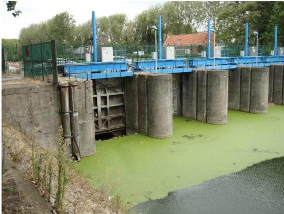
Barrage vanné de jonction : Batardeau déversant sur la vanne n°1, en gestion d'été
