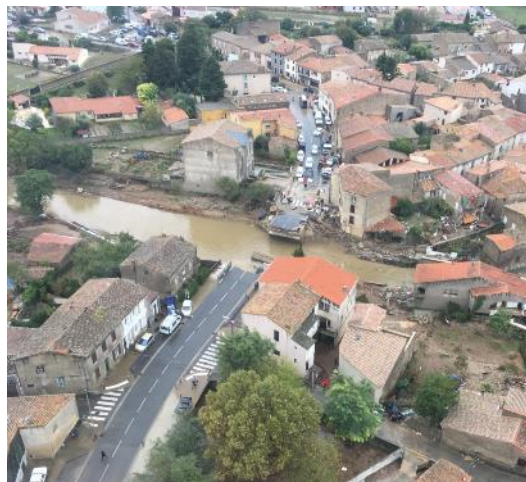
Vues du pont de la RD118 sur le Trapel à Villegailhenc le lendemain de la crue
