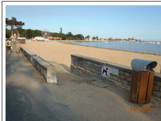
Vue sur point bas - rupture de la protection pour accès à la plage
