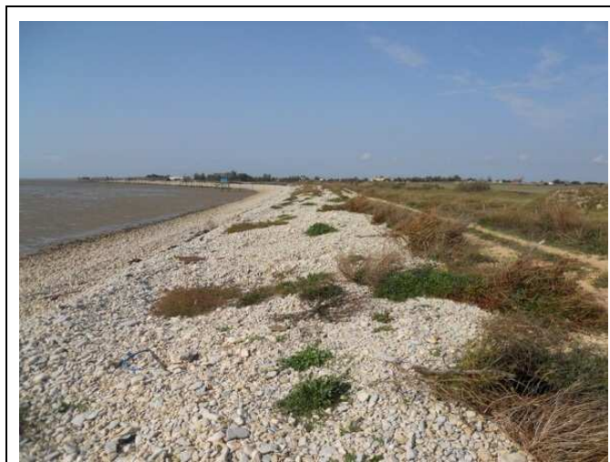
Vue sur la digue de l'anse de Fouras
