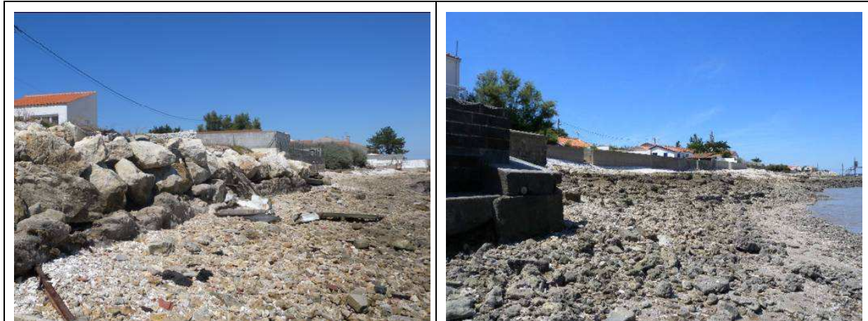
Vue sur les ouvrages du boulevard de La fumée
