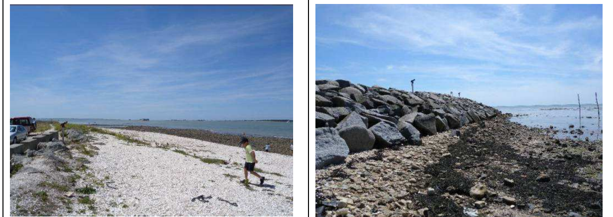
Vue sur les ouvrages de l'embarcadère
