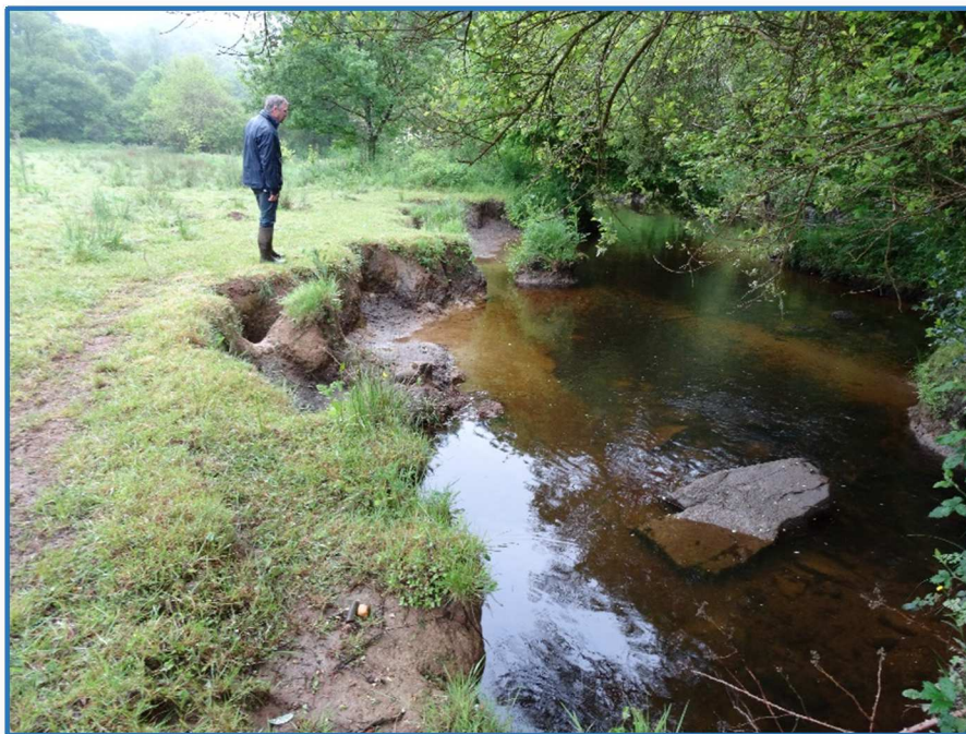
Figure 3 : Berges effondrées sur l'Ellez à Moulin Kerroc'h (P. Laugier – EPAGA)
