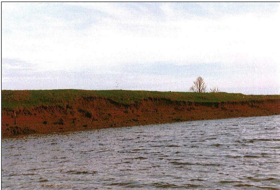
Figure 9 : Digue du Lay entre le Braud et Moricq - Erosion de digue (AS de la Vallée du Lay, 2000)
