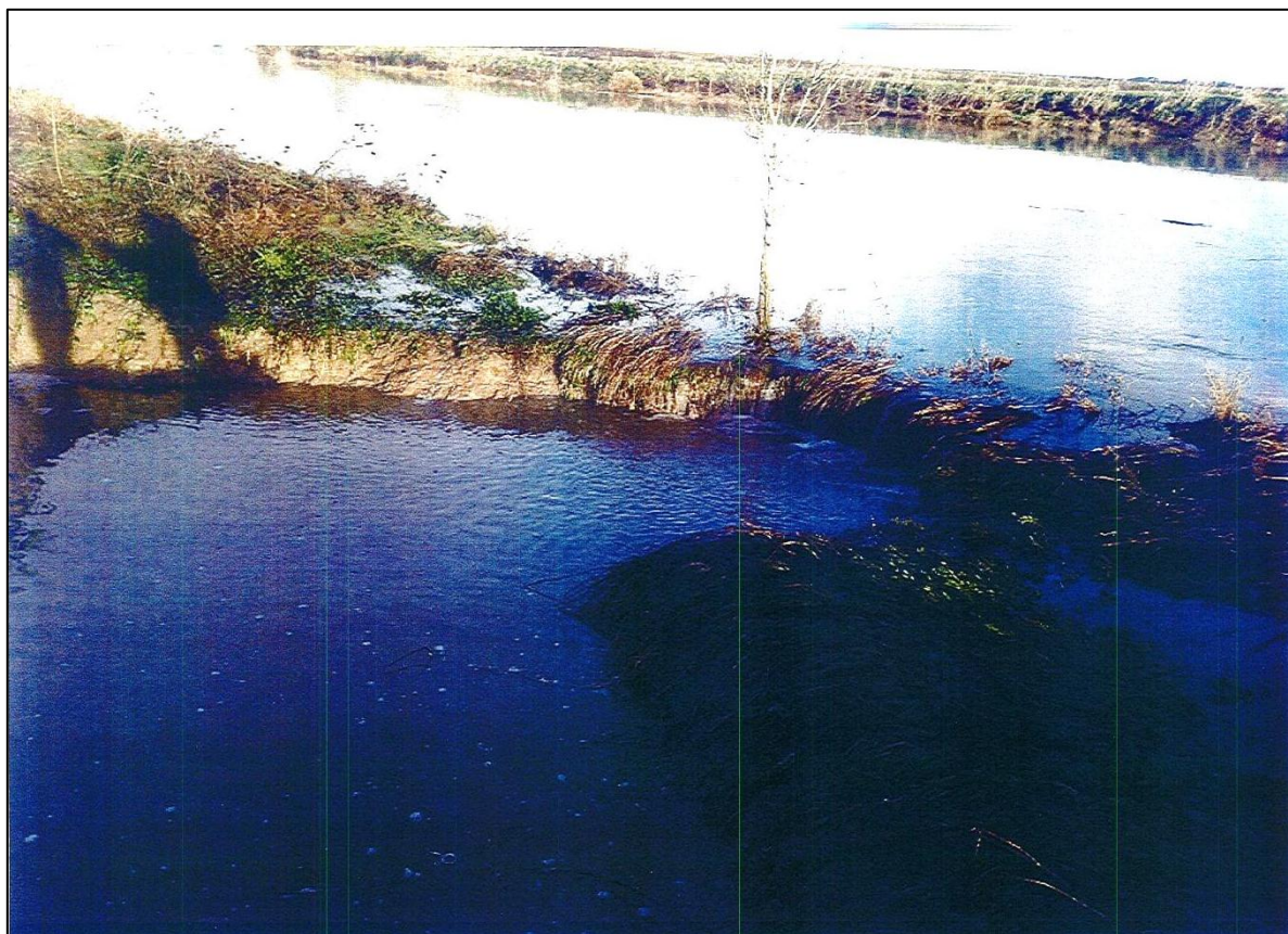
Figure 19 : Photographie de la brèche du 1 er février 2014 (ASA de la Vallée du Lay, 02 février 2014)
