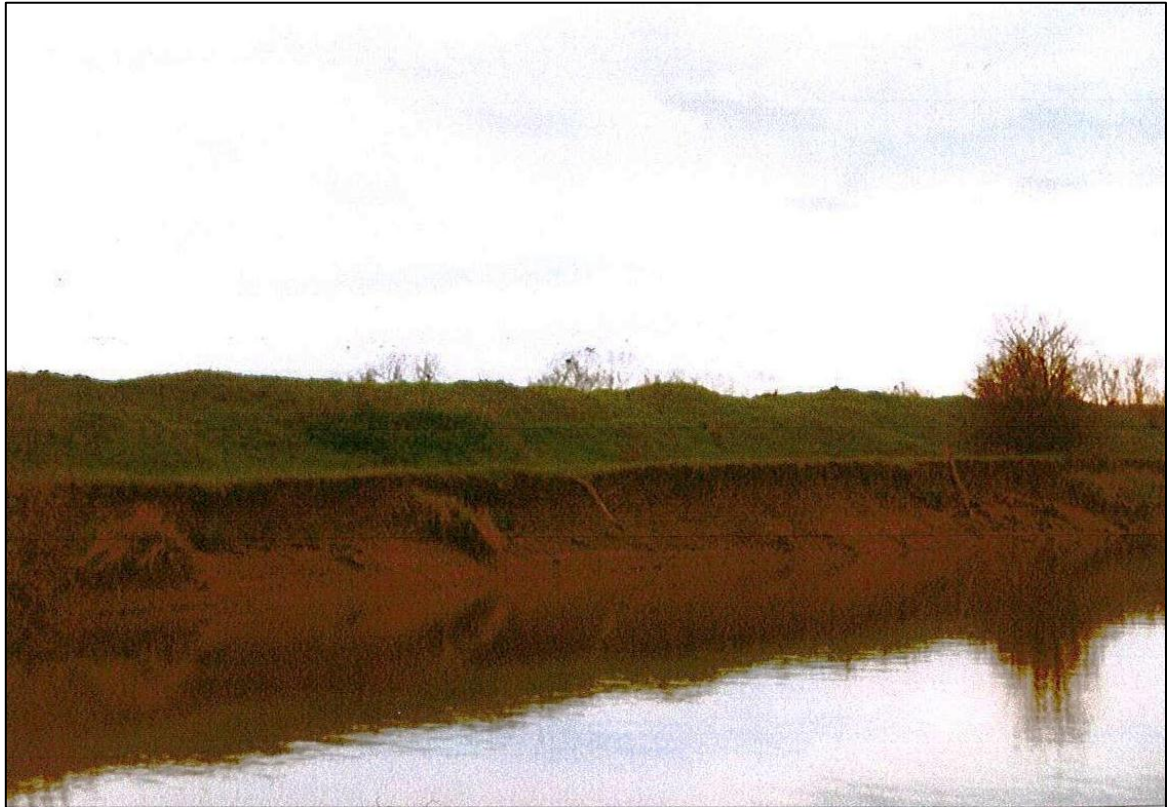
Figure 8 : Diques du Lay entre le Braud et Morigq - Erosion du pré-Lay (AS de la Vallée du Lay, 2000)
