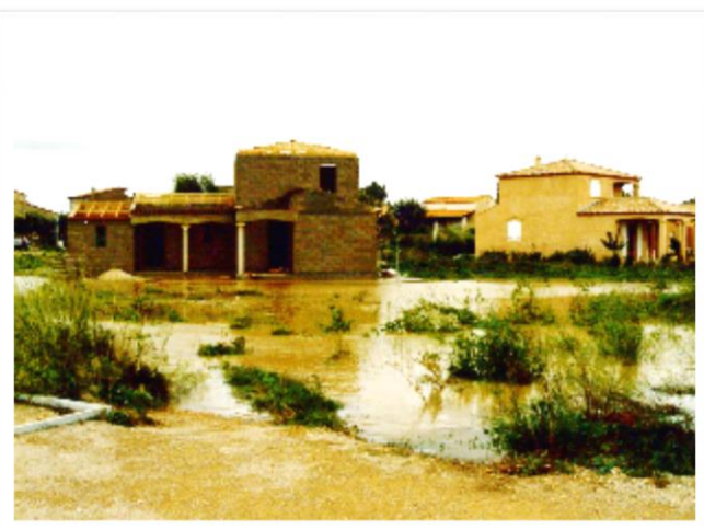
Lotissement de l'Esplanade, crue du Dardaillon Ouest, 21 septembre 1994
