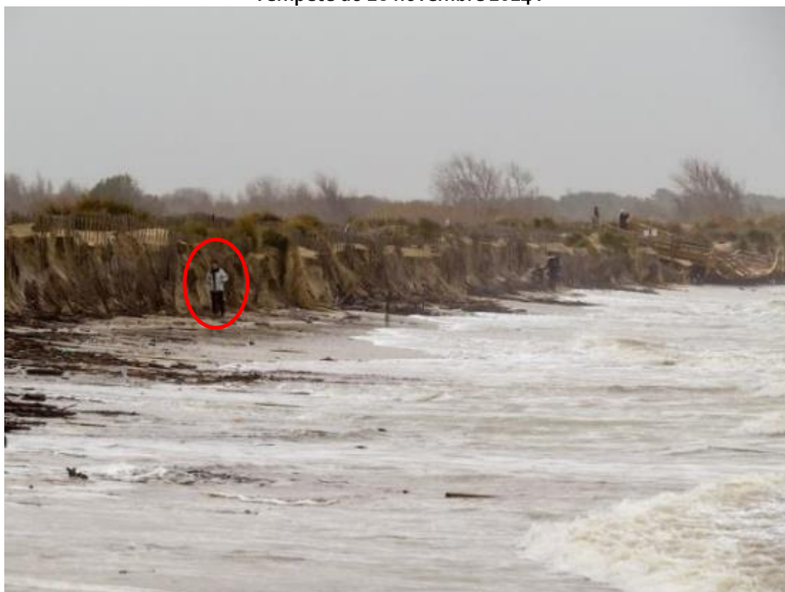
Commune de Mauguio-Carnon – Secteur du Petit Travers – Erosion marquée et recul du cordon dunaire
