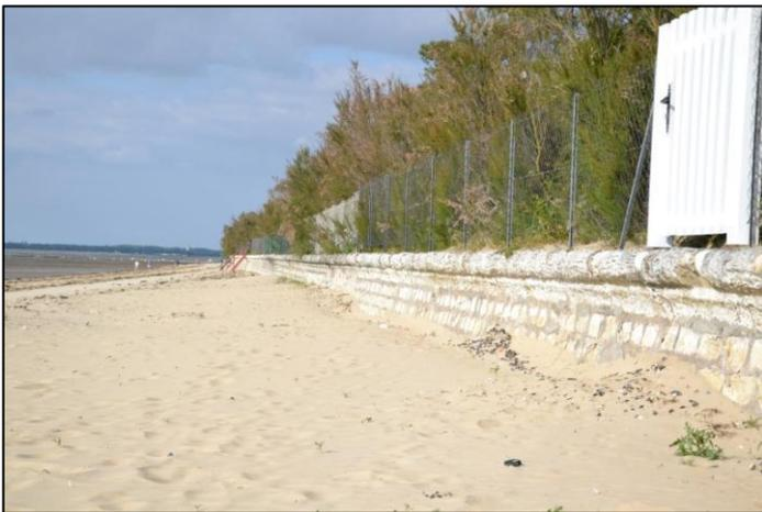
**Photo 19.** Brise-lame sans enrochement (*source : SMASS*)
