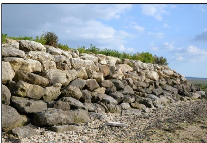
**Photo 21.** Digue en terre et enrochement
