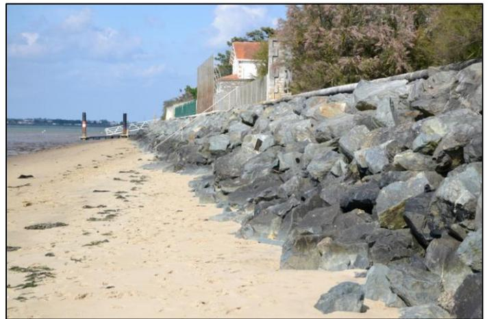
**Photo 20.** Brise-lame avec enrochement (*source : SMASS*)
