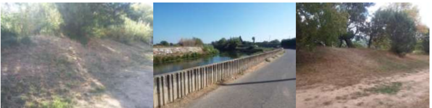
Figure 2. 48 – Photos de digues du Gapeau (Solliès-Pont, Hyères, Signes)
