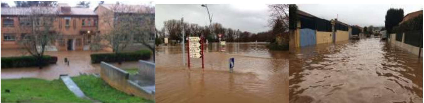
Figure 2. 25 – Photos de l'inondation du Gapeau et du Réal Martin de janvier 2014 (à gauche, CH Henri Guérin de Pierrefeu-du-Var, au centre, entrée de Pierrefeu-du-Var, et à droite, quartier de l'Oratoire à Hyères (crédits photos : Association V.I.E, mairies de Pierrefeu-du-Var et d'Hyères-les-Palmiers)
