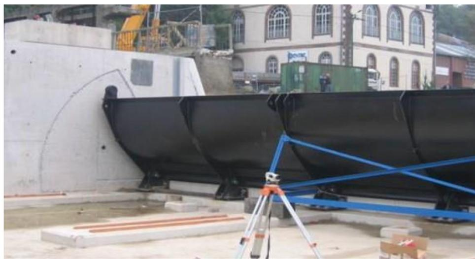
Figure 67 : Illustration d'une vanne-clapet (Grand-Barrage à Hennebont)
