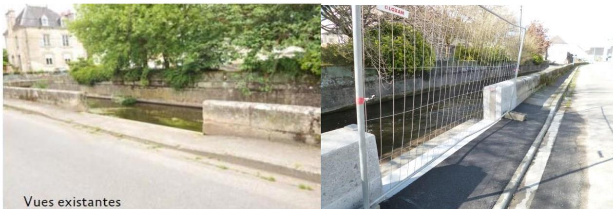
Figure 63 : Rue des trois frères Cornec avant et après travaux : Dispositif anti-crue = barrières amovibles à poser dès activation du PCS
