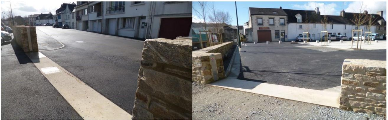
Figure 59 : Entrée de parking - partie Nord du muret anti-cruie Ouverture - partie Sud du muret anti-cruie, permettant le déplacement du halage à la place de la Fontaine
