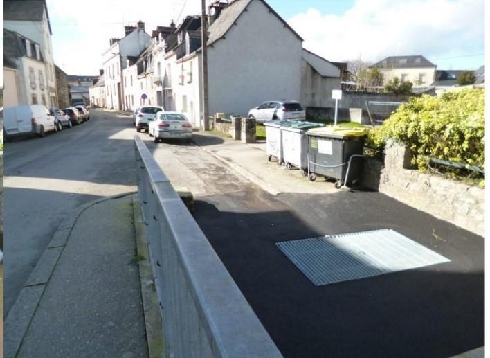
Figure 61 : Rue des moulins après travaux : muret anti-crue + dispositif pluvial mis en place
