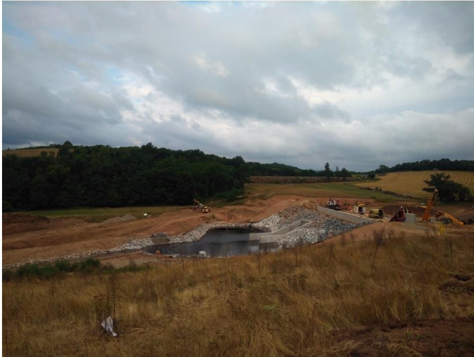
Ouvrage de St Romain de Popey après la remise en eau
