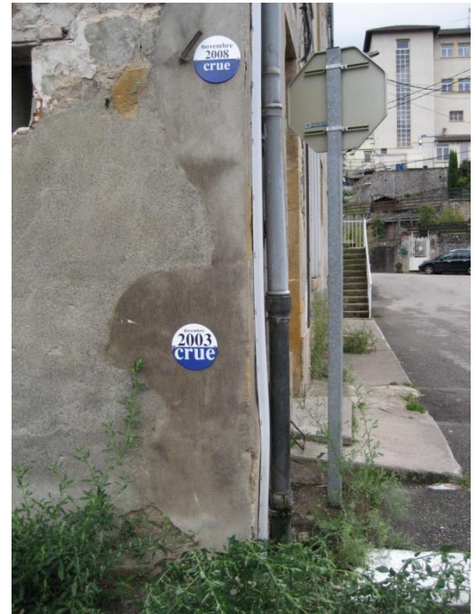
Repères des crues de décembre 2003 et novembre 2008 installés par le SYRIBT
