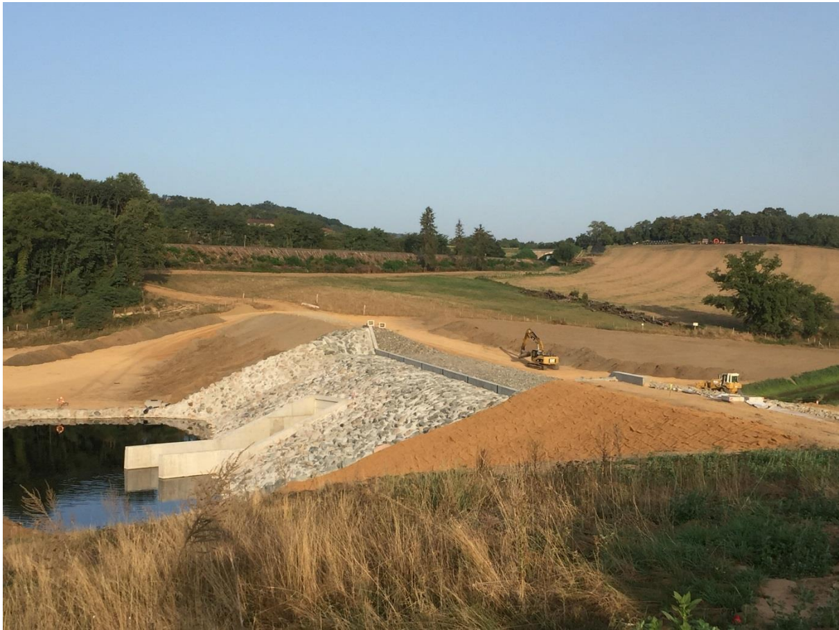
Vue aval de l'ouvrage
