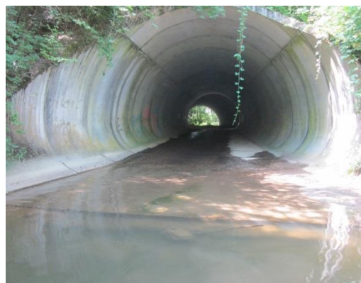
Vue aval buse RN7
