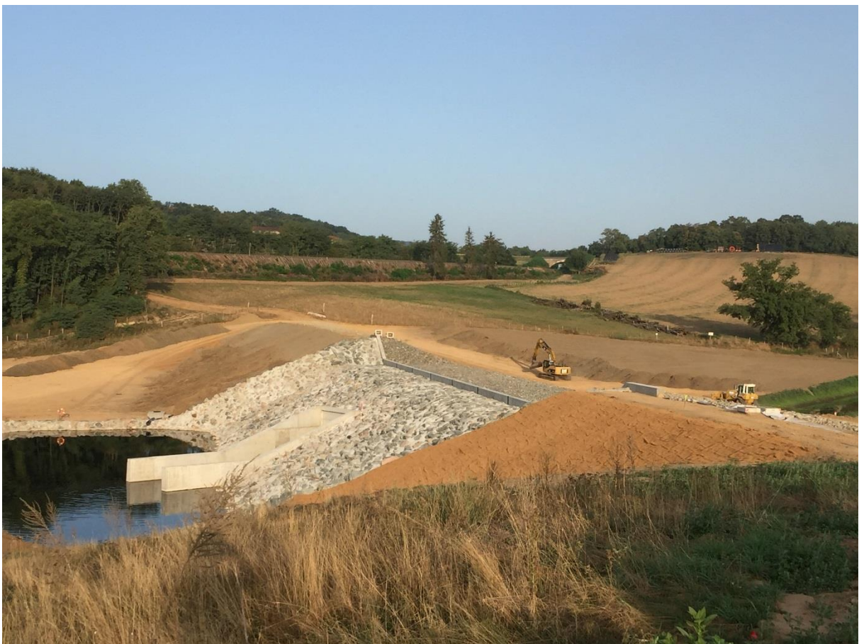
Vue aval de l'ouvrage
