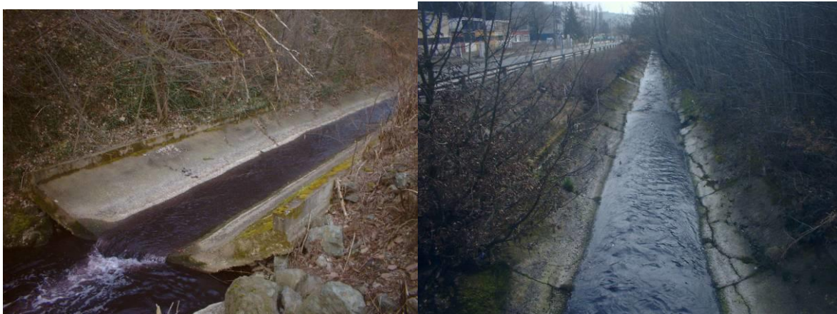
La Turdine en aval de Tarare : "cunette béton"
