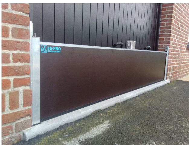
Dispositif de protection individuelle pour une habitation
