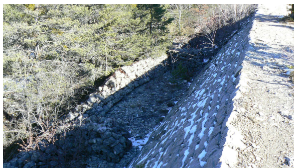
Illustration 6: Digue et gabions en rive gauche du Rif de l'Arc
