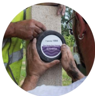
Pose d'un repère de crue Commune de Céreste
