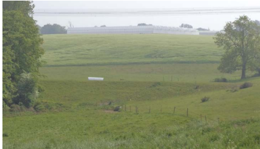
Figure 3-11 : Exemple d'ouvrage de rétention en vallée sèche, bassin versant de la Saône (76)
