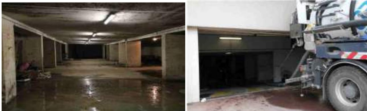
**Fig. 7. Quartier de la Bocca : niveau -2 du garage souterrain : boue au sol et au plafond (à gauche) ; opération de pompage de la boue (à droite)**
