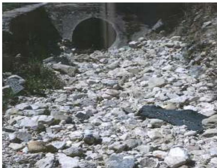
Figure 25. Buse de diamètre 800mm avec accumulation de matériaux suite à la crue du 09 août 2018
