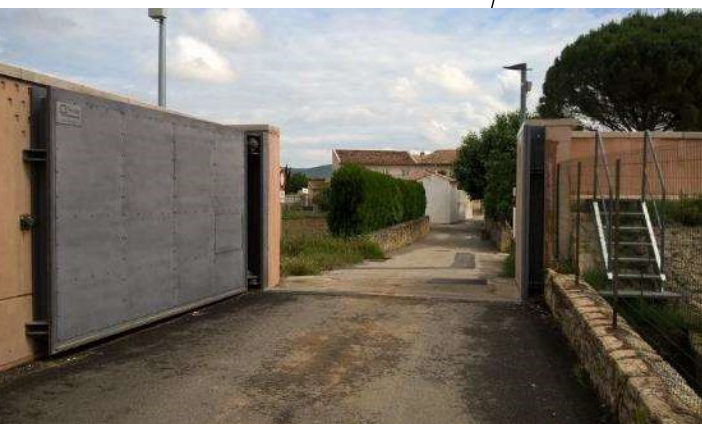
Figure 15. Localisation de la digue des Tuillères à Pont Saint Esprit
