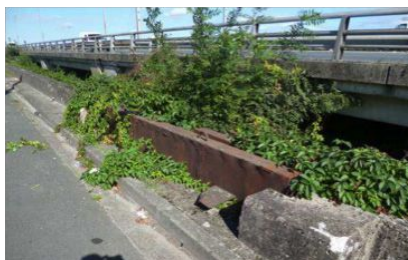
← Muret et batardeau
