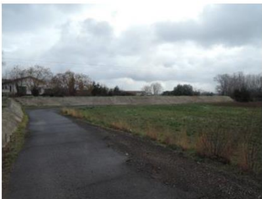
digue de ceinture d'Usclas RD
