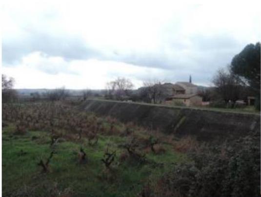
digue de ceinture d'Usclas RD nord
