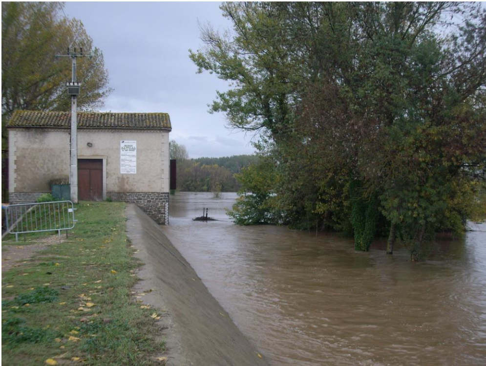
Digue de protection rapprochée basse vallée de l'Hérault– photo SMBFH
