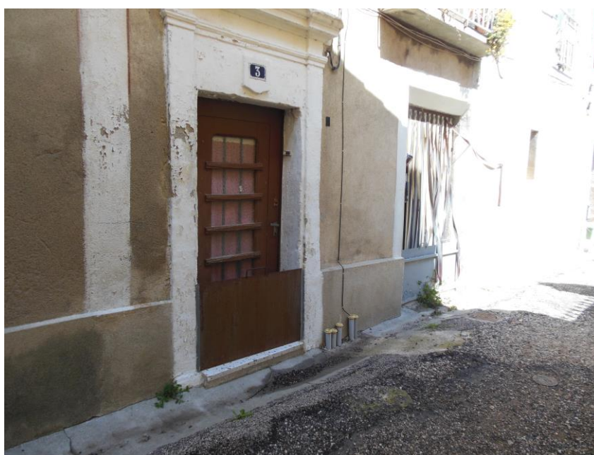
Exemple de batardeau – photo SMBFH
