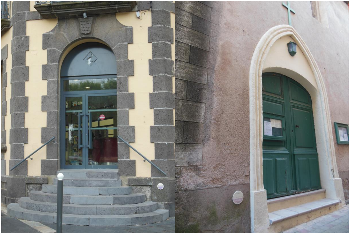
Macarons de crue du BV de l'Hérault et repères posés – Office du Tourisme d'Agde et Eglise de Bélarga – photos SMBFH
