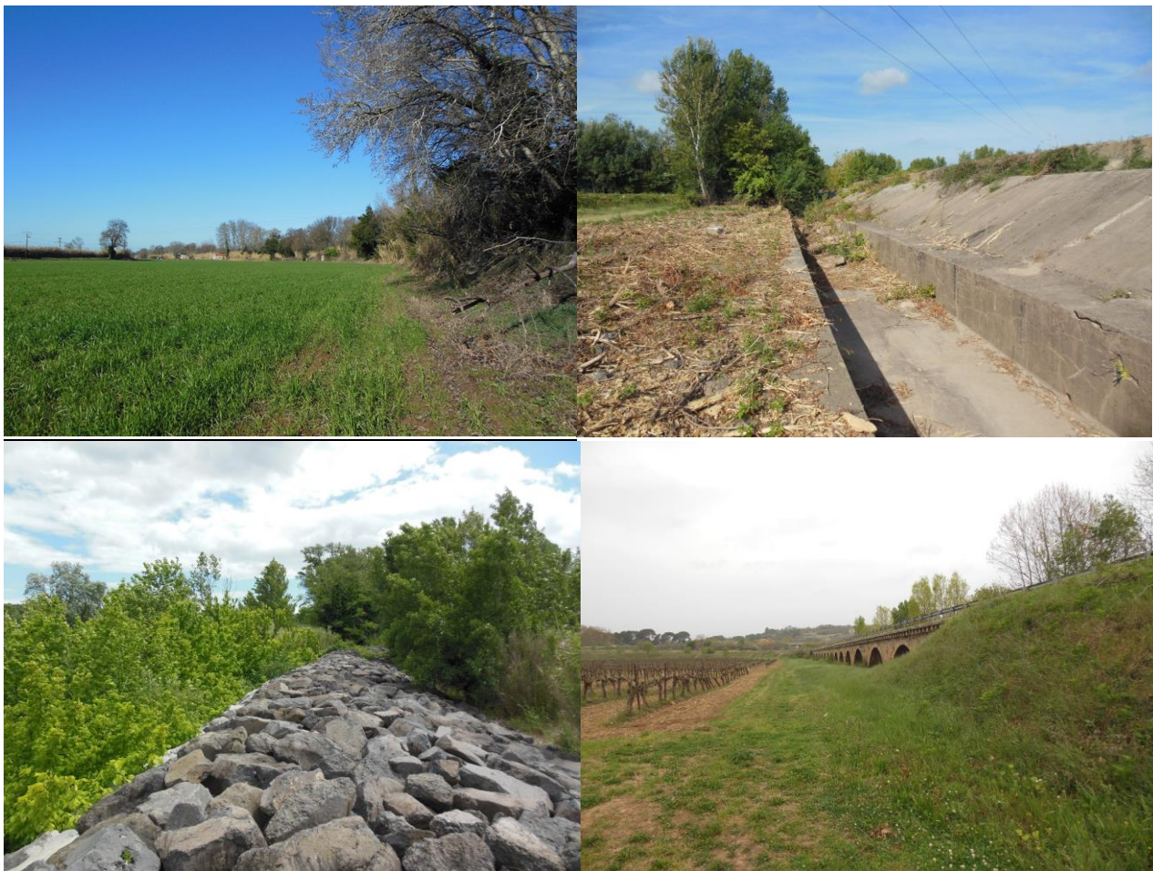
Ouvrages et infrastructures de la plaine de l'Hérault- photos SMBFH
