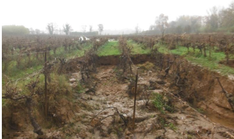
Brèche dans une vigne en bord d'Hérault – crue de l'automne 2014 – photo SMBFH
