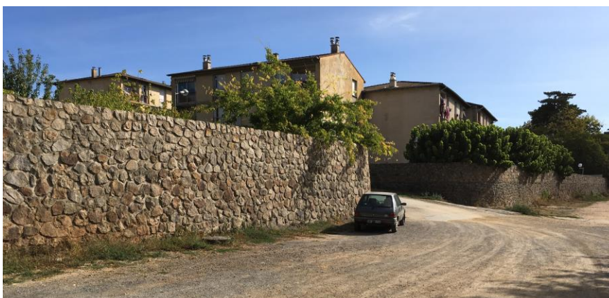
Digue de Saint-Jean-du-Gard
