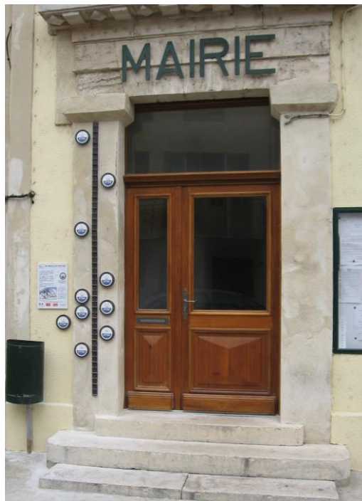
Repères de crue sur la mairie de Comps
