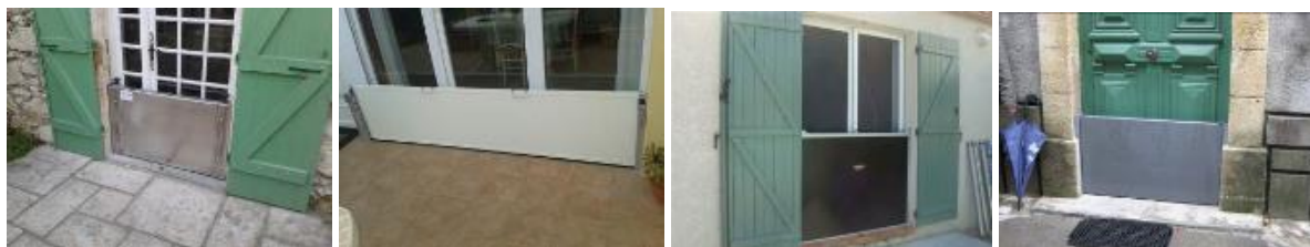
Exemple de batardeaux posés dans cadre d'ALABRI en Gardonnenque
