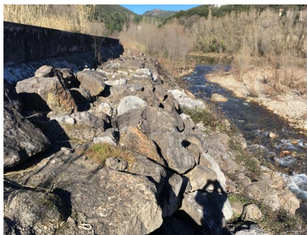
Enrochement de protection de la digue de l'Habitarelle
