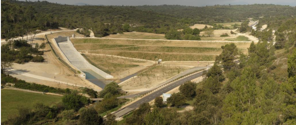
Vue aval du barrage de Saint-Geniès-de-Malgoirès
