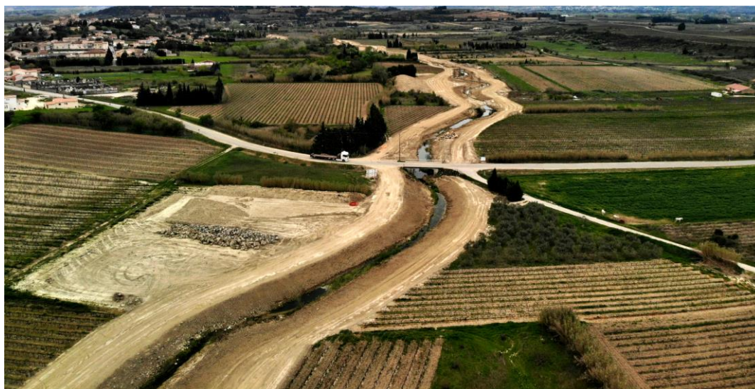
Chantier d'effacement des digues en cours à Théziers
