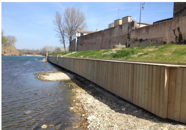
Digue de Remoulins
