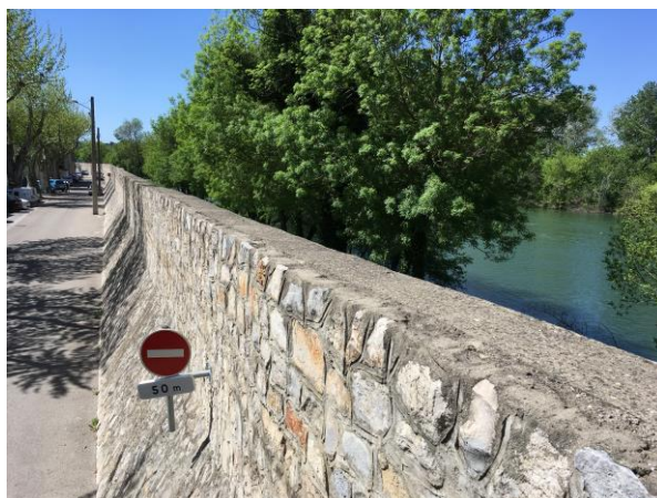
Digue de Comps
