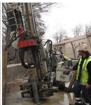
Confortement de la digue d'Anduze et forage de micropieux pour la digue de Remoulins
