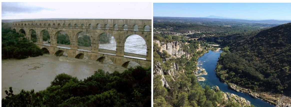
Pont du Gard lors de la crue de septembre 2002 et les gorges du Gardon à Collias
