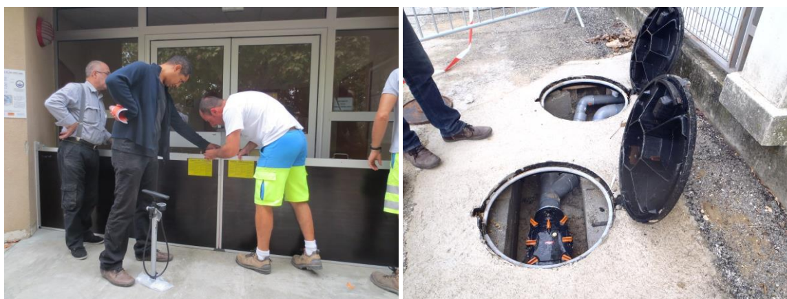
Installation des batardeaux à Ners et clapet anti-retour à Saint-Geniès-de-Malgoirès
