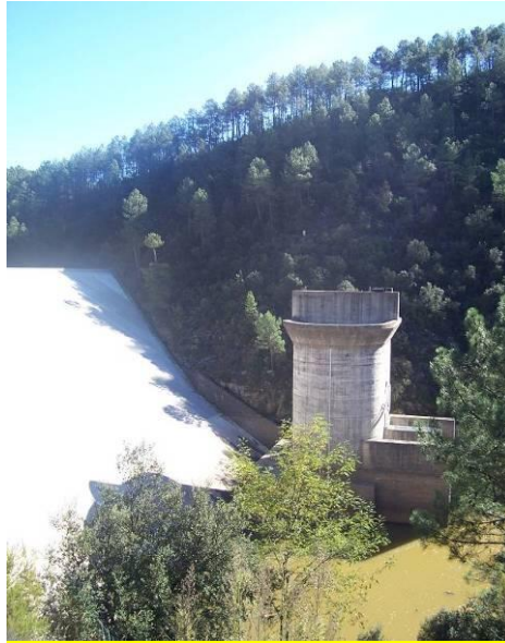
Figure 1 : Photo de l'amont du barrage de Sainte-Cécile-d'Andorge
