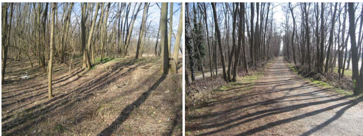
Figure 17 : Photographies des digues actuelles – tronçon 1.1
