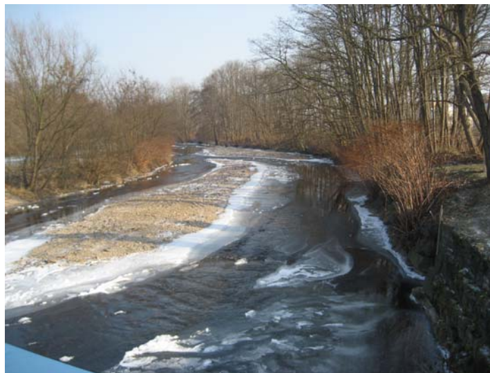
Figure 9 : Formation de bancs en aval de la RD1083
