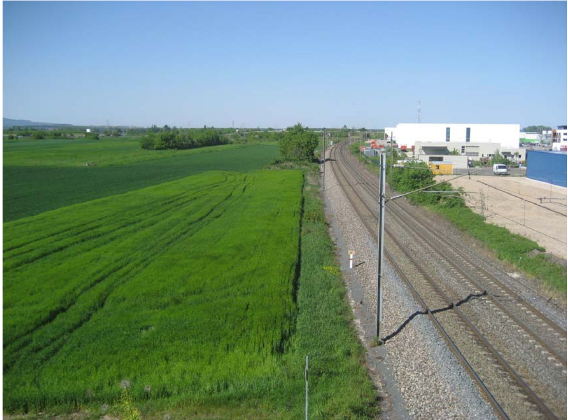
Figure 19 : Vue de la zone de protection de la digue 1 en amont de la voie ferrée
