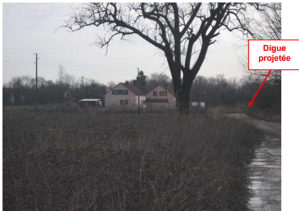
Figure 20 : Vue des habitations situées en arrière immédiat du tronçon 1.2
