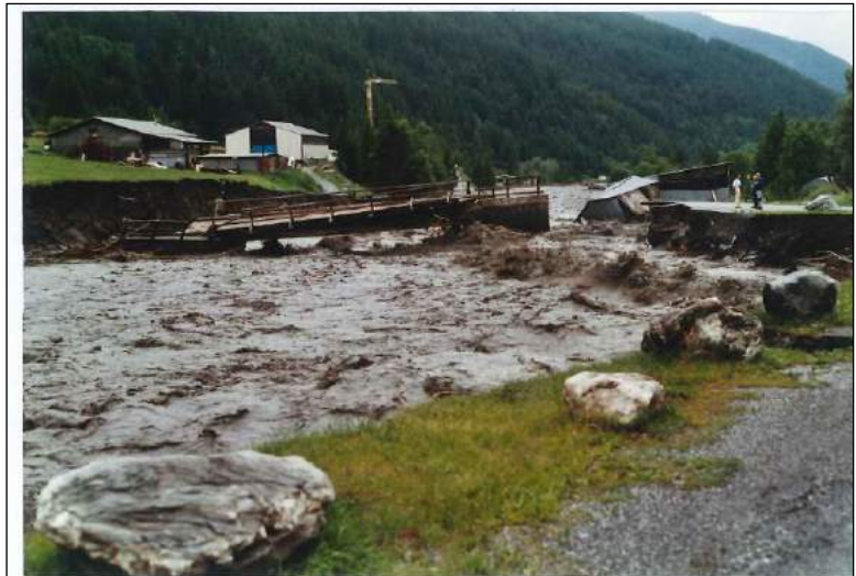
Photographie 4 : pont de la zone artisanale sur la commune d'Aiguilles – PNRQ, juin 2000
