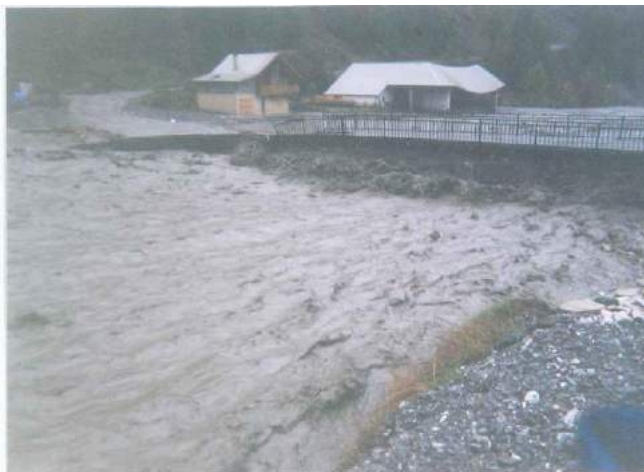
Photographie 9 : Engravement du pont du Guil, sur la commune d'Aiguilles – PNRQ, octobre 2000
