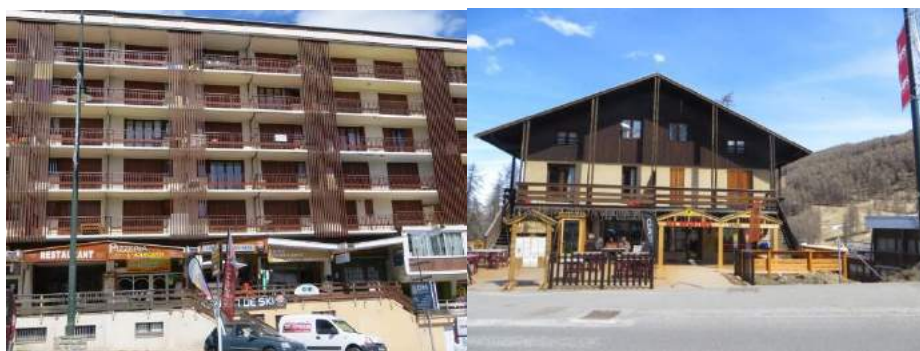
Photographies 16 et 17 : restauration en RDC d'immeuble touristique et de chalet à Vars
