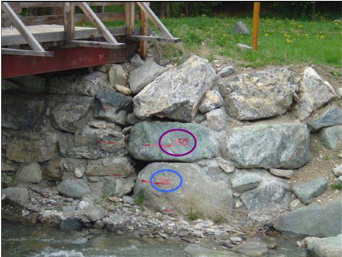
Repères matérialisés sur la culée rive gauche
