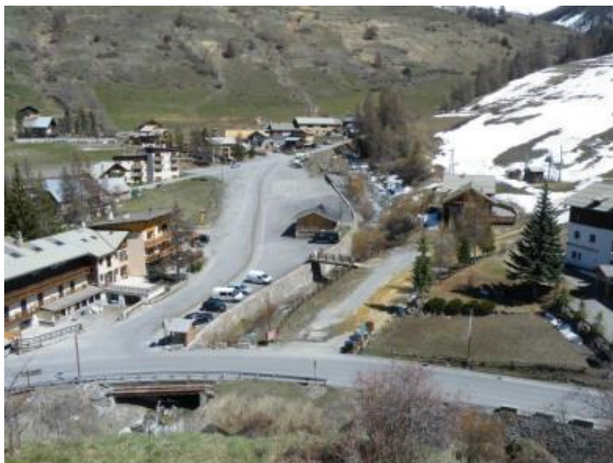
Photo 1 : torrent du Chagnon dans la traversée de Sainte Marie et le pont de la RD au premier plan
