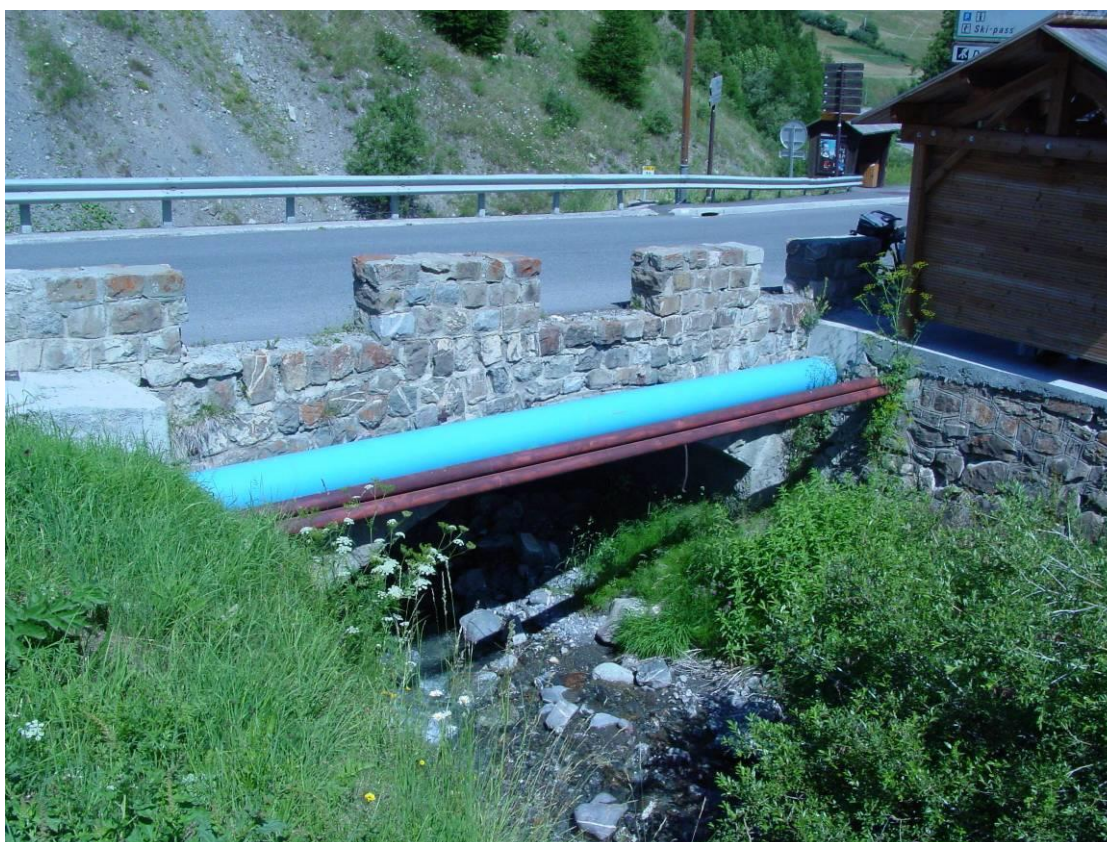
Photo 2 : pont du Chagnon amont
