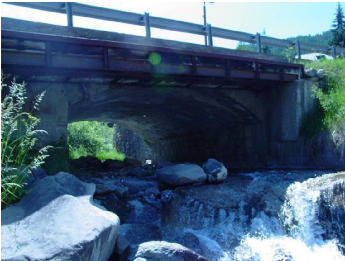
Photo 1 : pont du Chagnon aval
