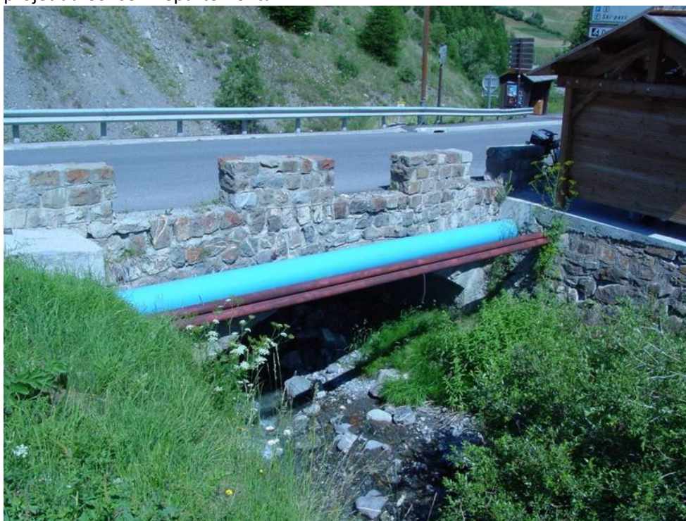
Photo 1 : pont du Chagnon en amont
