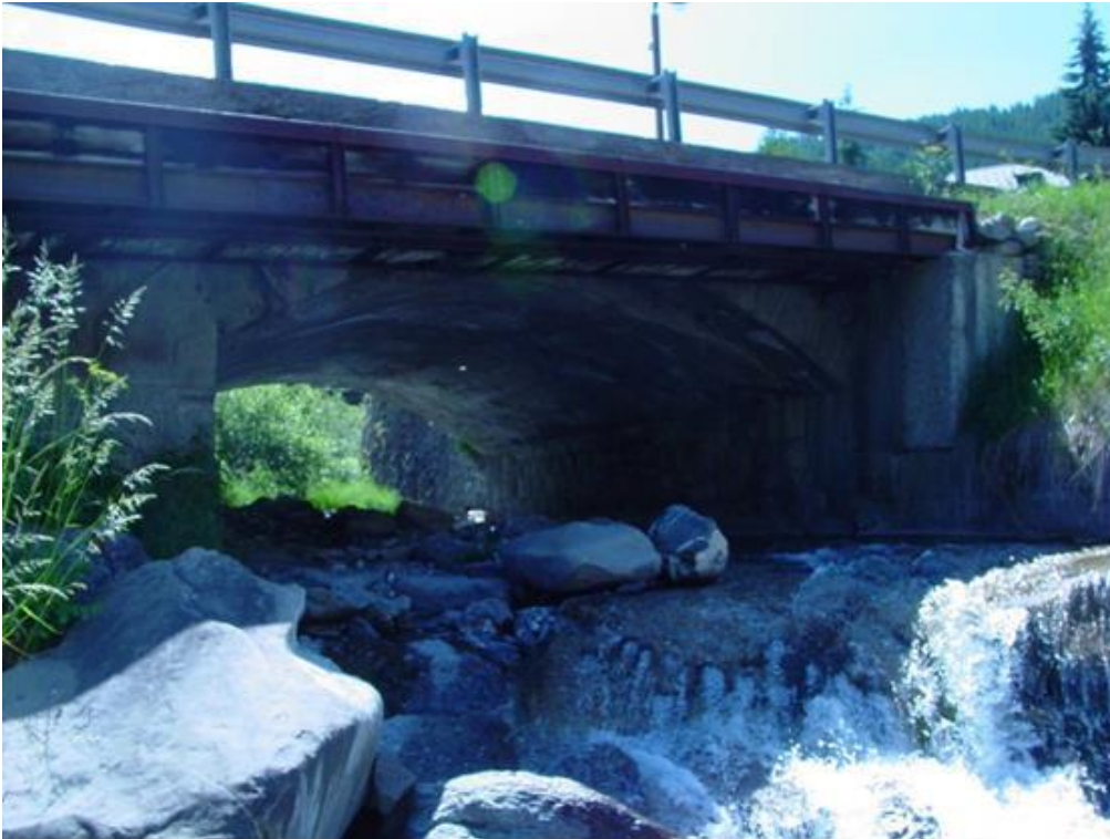
Photo 2 : pont du Chagnon en aval – mise en place d'un seuil de franchissement
