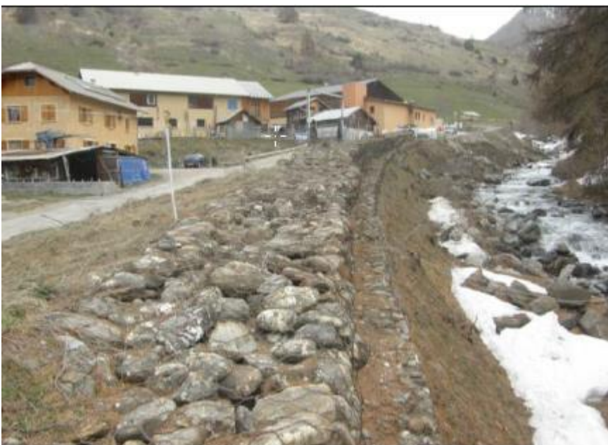
Photo 2 : digue en remblais (extrait du diagnostic de digue, RTM, 2013)
