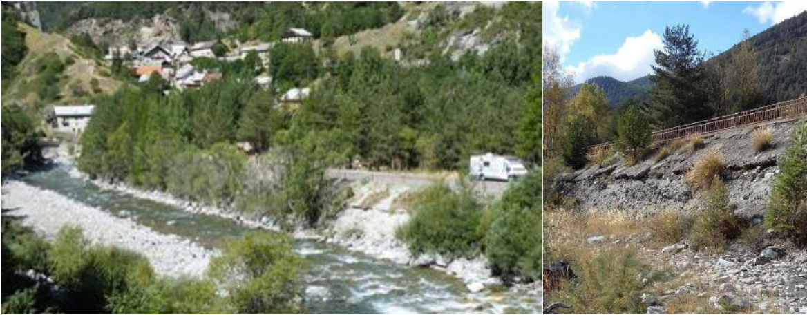
Photos 2a et 2b : reprise des protections de berge en rive droite
