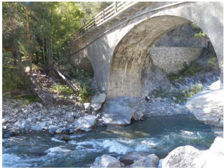
Photo 3 : dégagement de la deuxième arche du pont (en rive gauche)
