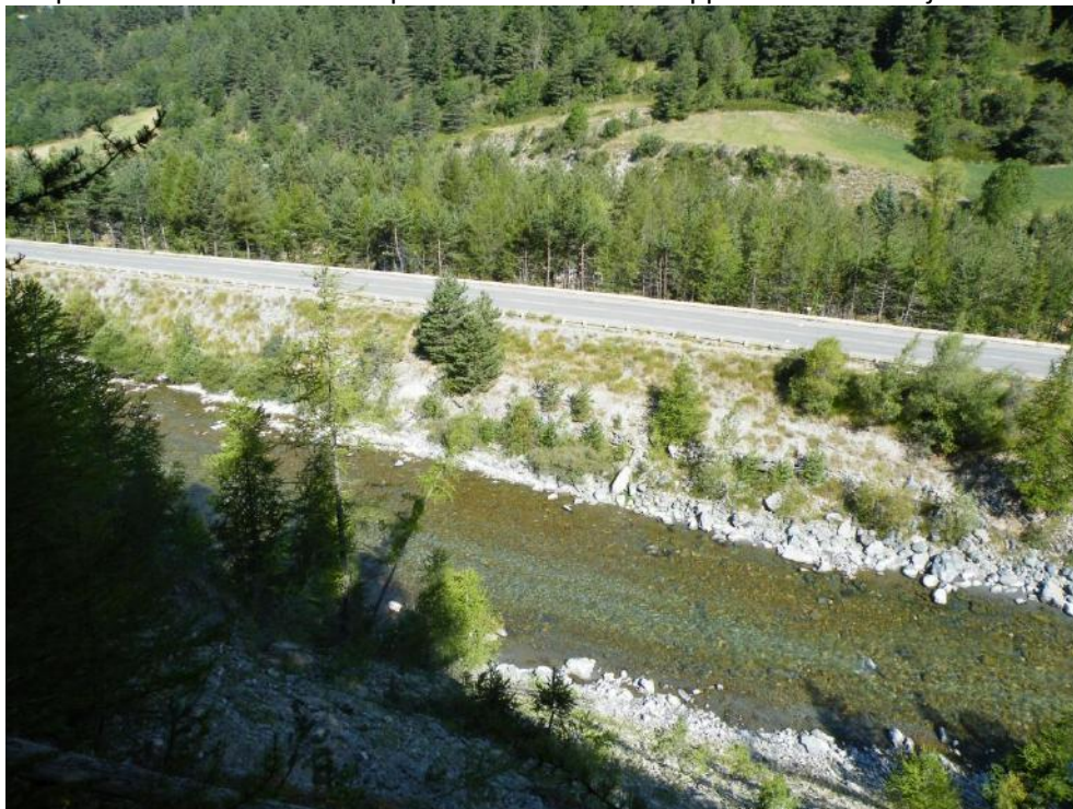
Photo 1 : la digue soutenant la RD et contraignant l'espace de mobilité du Guil
