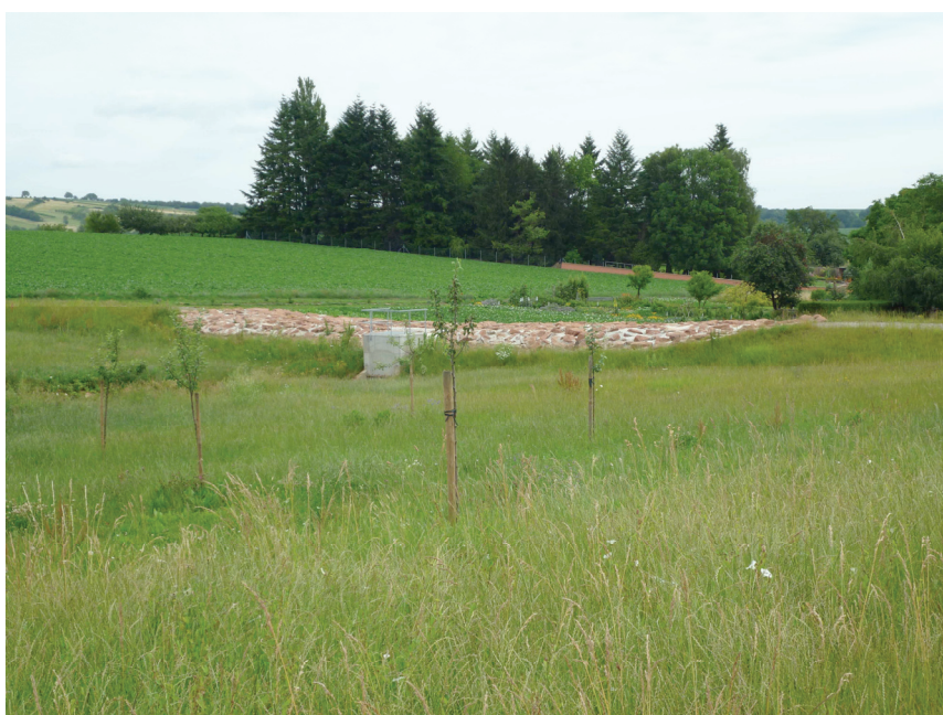
Visite des bassins de rétention à Alteckendorf
