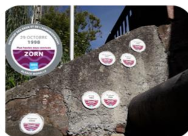
Pose de repères de crue
