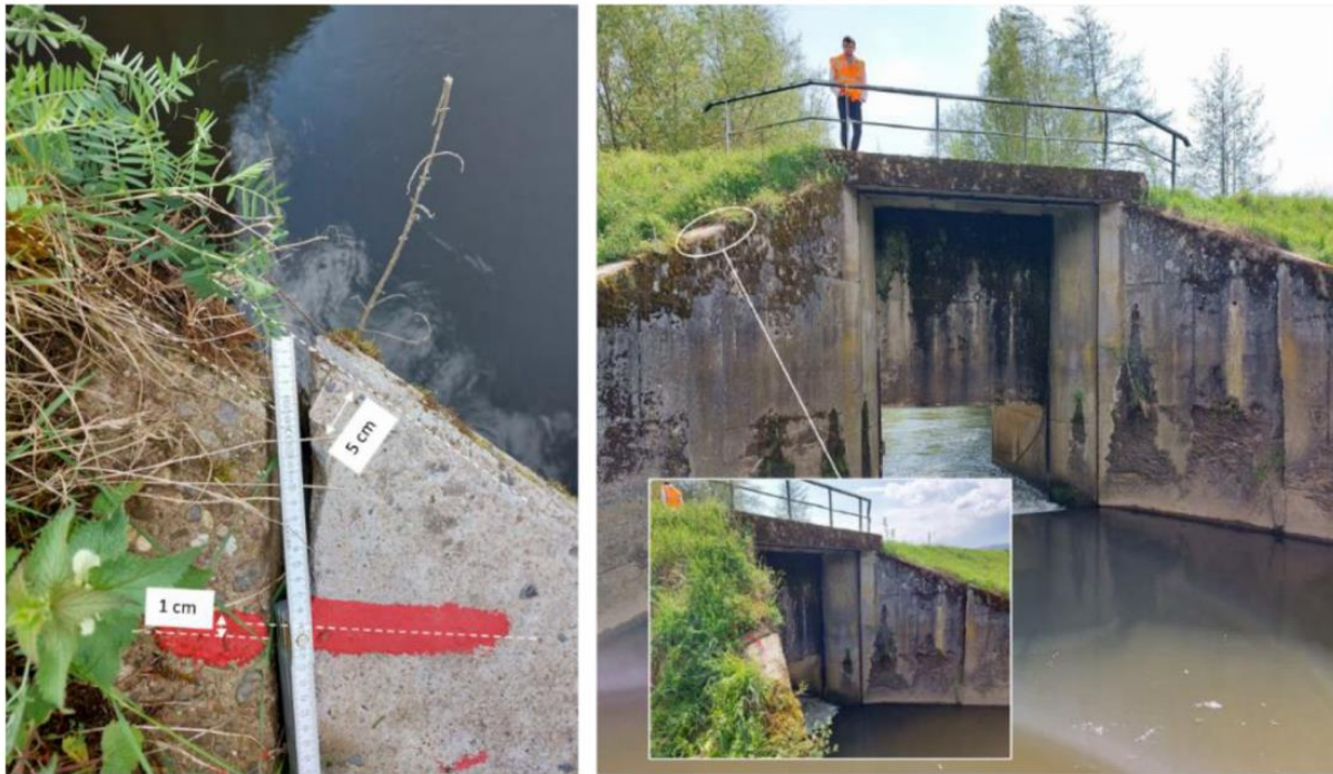
Figure 5: Bajoyers amont du limiteur de crue, rive gauche (ARTELIA, 2022)
