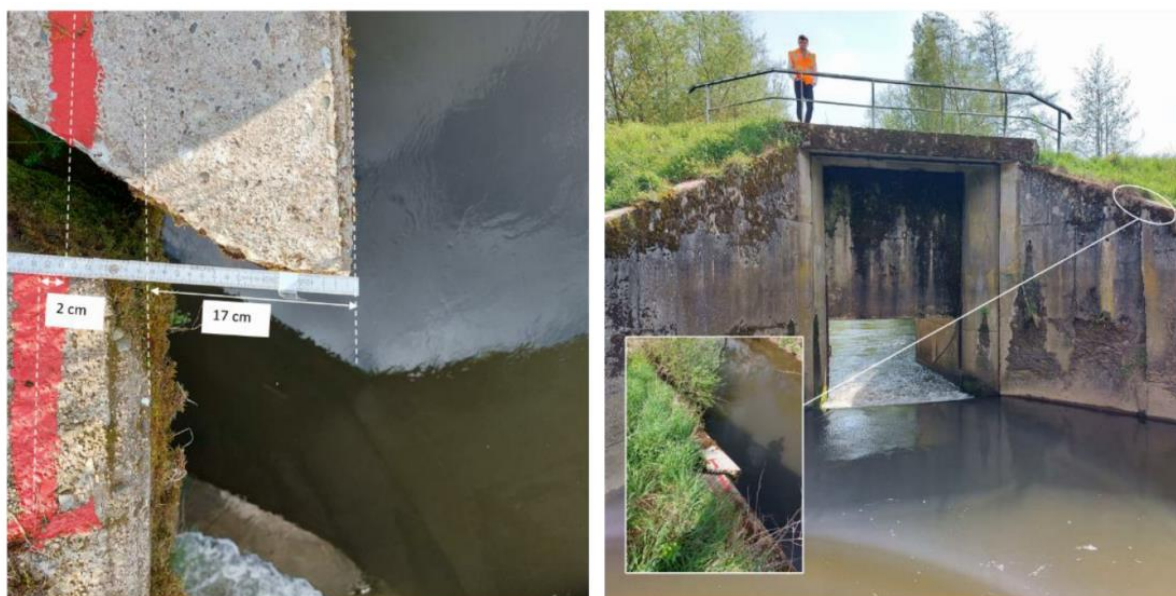
Figure 4: Bajoyers amont du limiteur de crue, rive droite (ARTELIA, 2022)
