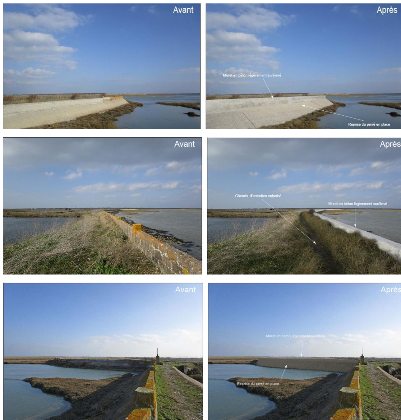
Exemple d'évolution du paysage au niveau de la digue de la prise Neuve
