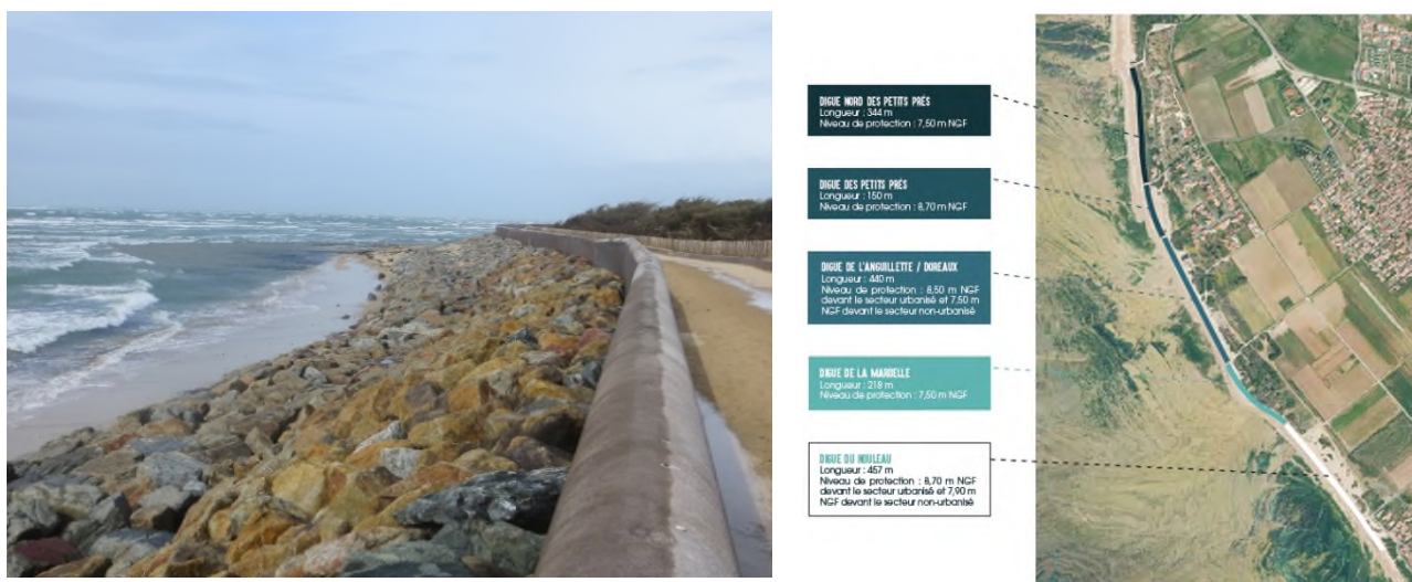
Figure 27 : Vue des protections de la façade ouest de Saint-Clément-des-Baleines et plan d'ensemble des différents tronçons. (source photo : ARTELIA, 2018 ; source plan : CDC Ile de Ré)
