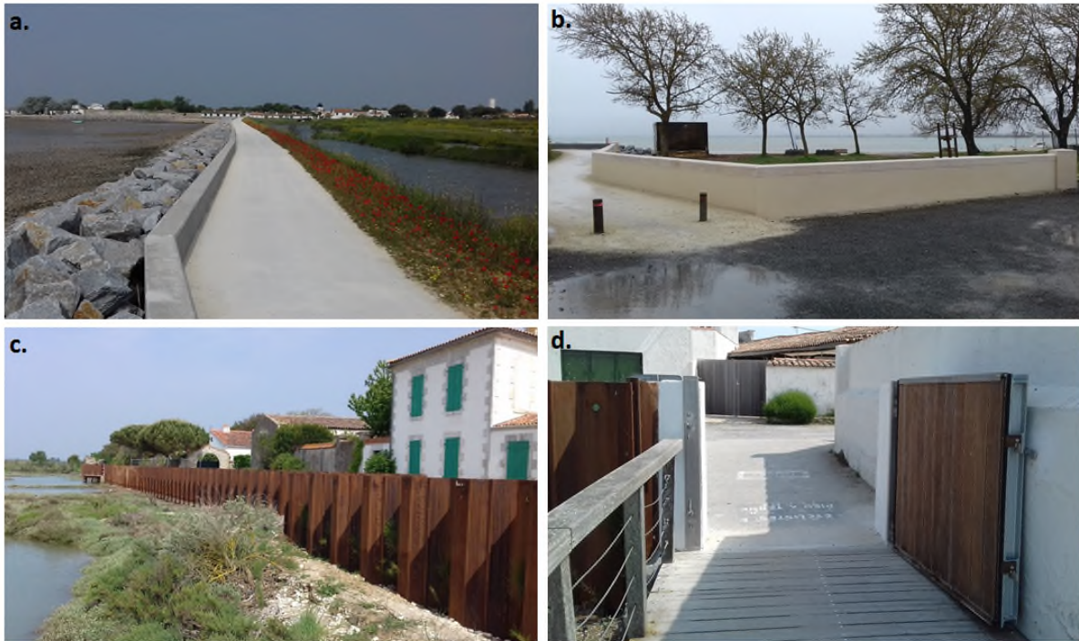
Figure 29 : Aperçu des différents ouvrages de protection réalisés à Loix : a. Digue de Cul d'Ane (source : CD 17, mai 2018) ; b. Mur anti-submersion de la place du Port (source : CD17, mars 2018) ; c. Rideau de palplanches du secteur ouest moulin à marée (source : CD 17, mai 2018) ; d. Portail anti-submersion à l'extrémité est du rideau de palplanches (source : CD 17, mai 2018)
