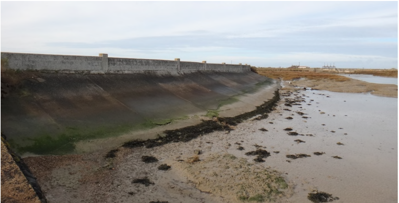
Figure 36 : Digue de Dieppe ( source : CDC Ile de Ré, 2018)
