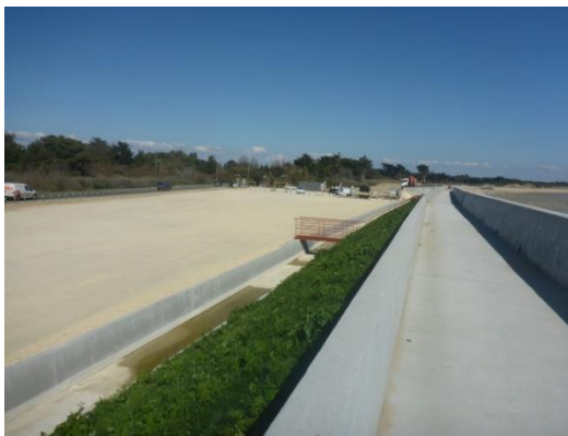
Vue de la digue côté terre
