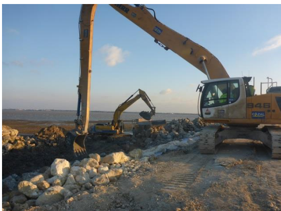
Mise en œuvre des enrochements
