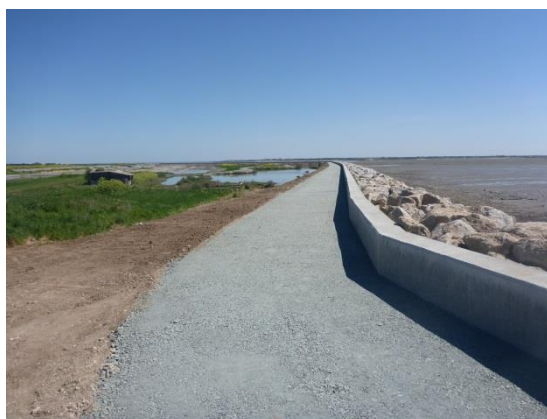
Muret et cheminement provisoire
