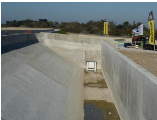
Système de ressuyage
