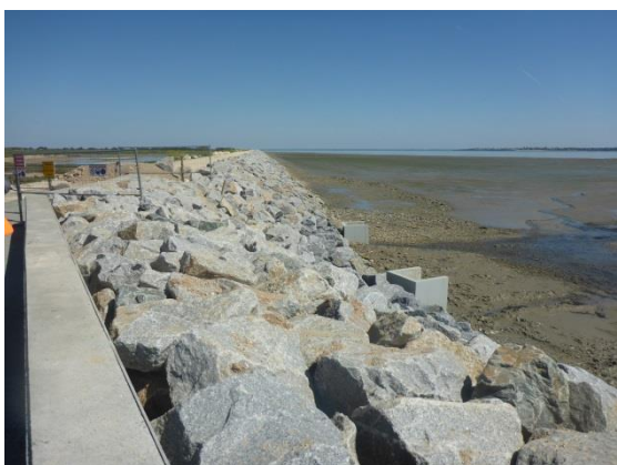
Enrochements – secteur Cul d'Ane
