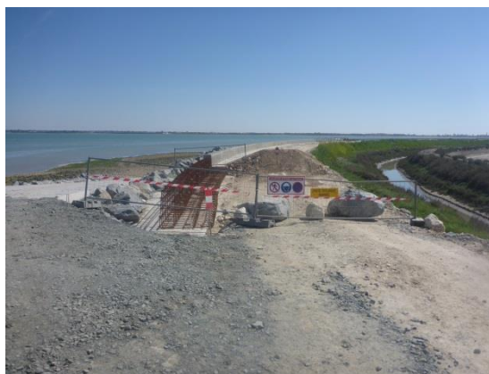
Mise en œuvre du muret sur les digues littorales
