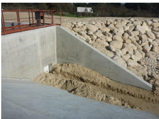
Exutoire du système de ressuyage
