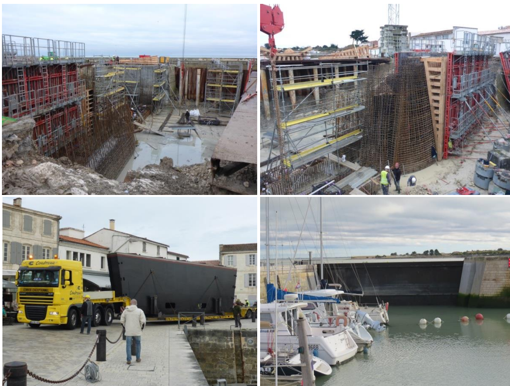
Construction de la porte coulissante
