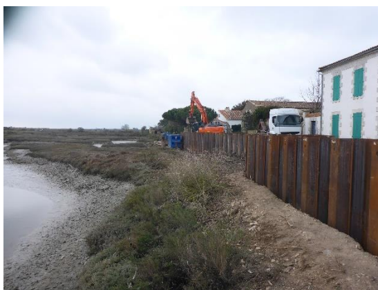
Mise en œuvre du rideau de palplanches Ouest Moulin
