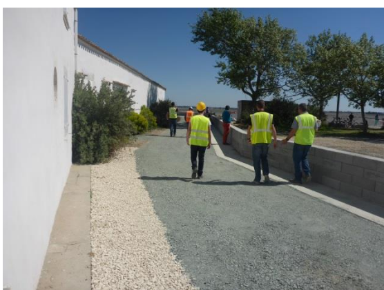
Mise en œuvre du muret – place du port
