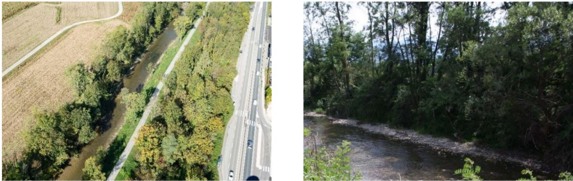
A gauche : vue aérienne de la Leysse dans le sens amont aval (digue RG à gauche de l'image) ; à droite : talus amont de la rive gauche vue de la rive opposée.
