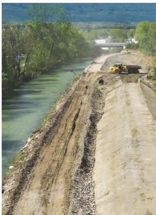
Restauration des digues de la Leysse – photographie Chambéry Métropole ©
