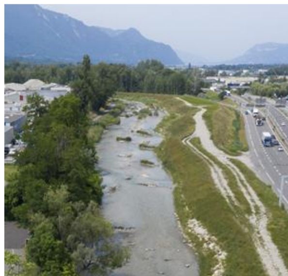
En élargissant sur sa rive droite [10 à 50 m], la Leysse retrouve un espace permettant la végétalisation et la diversification des habitats. 2019.
