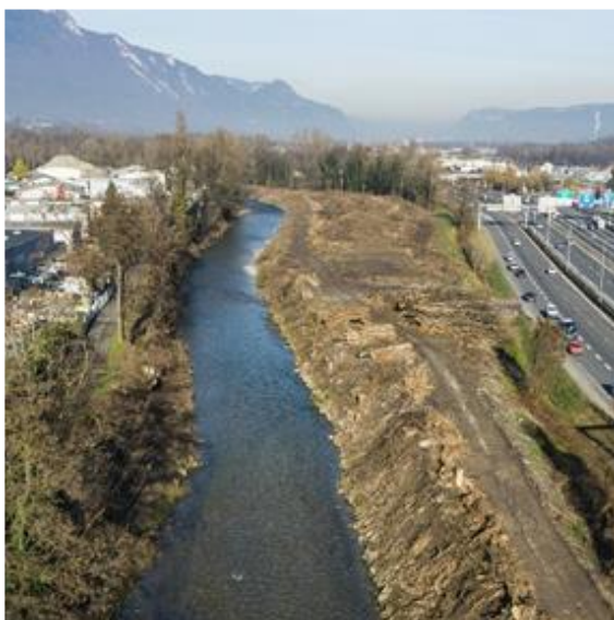
Les travaux de déboisement mettent à nu une rivière trop géométrique : rectiligne, endigué et sans habitats aquatiques. 2015.
