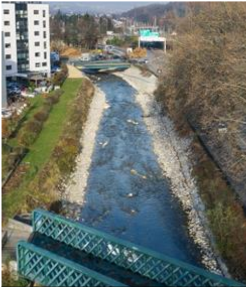
Augmentation de la section de la rivière dans un secteur où la Leysse a débordé en février 1990. 2015.
