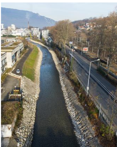
Augmentation de la section de la rivière et suppression de la digue rive gauche le long de l'éco quartier de Chambéry. 2015.
