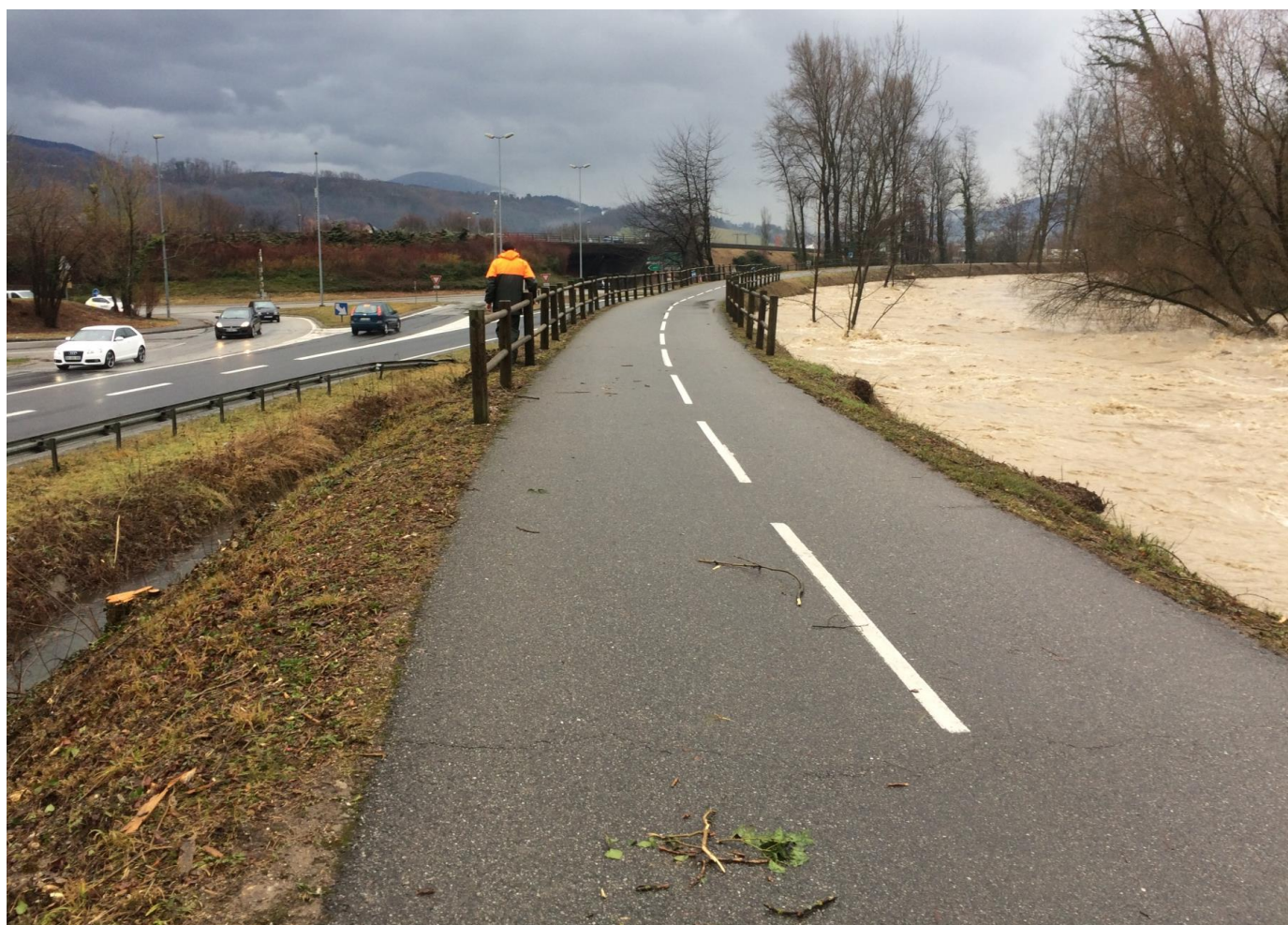
Digue étroite constituée de matériaux hétérogène : niveau de protection < à la crue décennale
