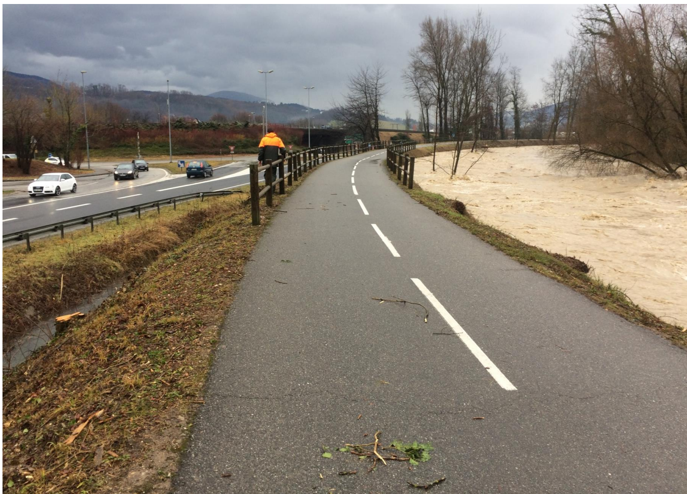
Digue étroite constituée de matériaux hétérogène : niveau de protection < à la crue décennale
