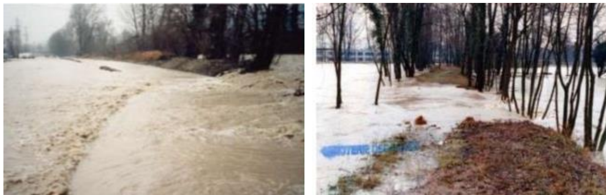
Figure 46 : Illustrations de surverses observées sur des digues du bassin versant
