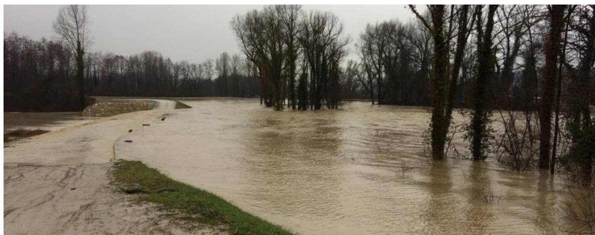
Figure 84 : La nouvelle Leysse et la surverse rive gauche lors de la crue du 4 janvier 2018 [A partir de 200 m 3 /s, la Leysse déverse bien dans un casier naturel et agricole]
