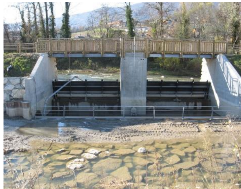
Figure 103 : Vannes du Bras de décharge de la Leysse
