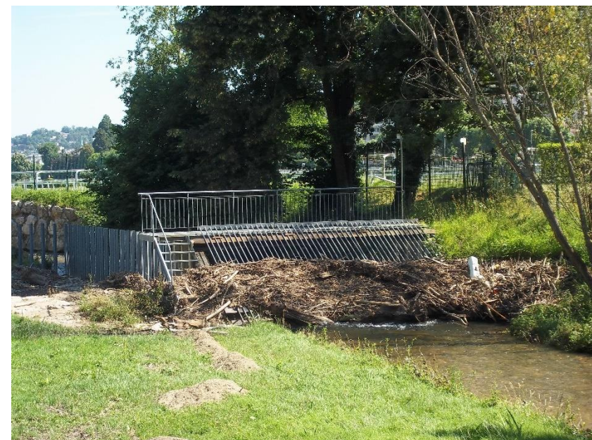
Figure 104 : Dégrilleur du Tillet
