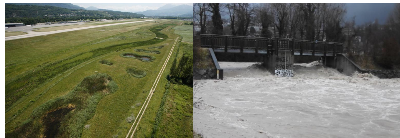
Figure 83 : Bras de décharge en mode « zone humide » et en mode « crue » le 4 janvier 2018
