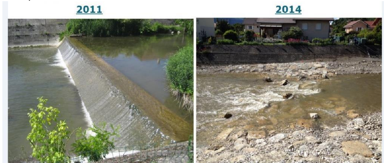
Figure 36 : Restauration du seuil du Pont Rouge (Aix-les-Bains)
