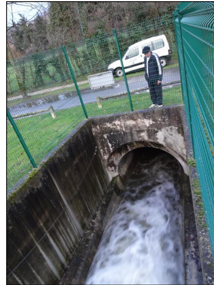
Figure 39 : Ouvrage de dérivation du Tillet vers le lac du Bourget
