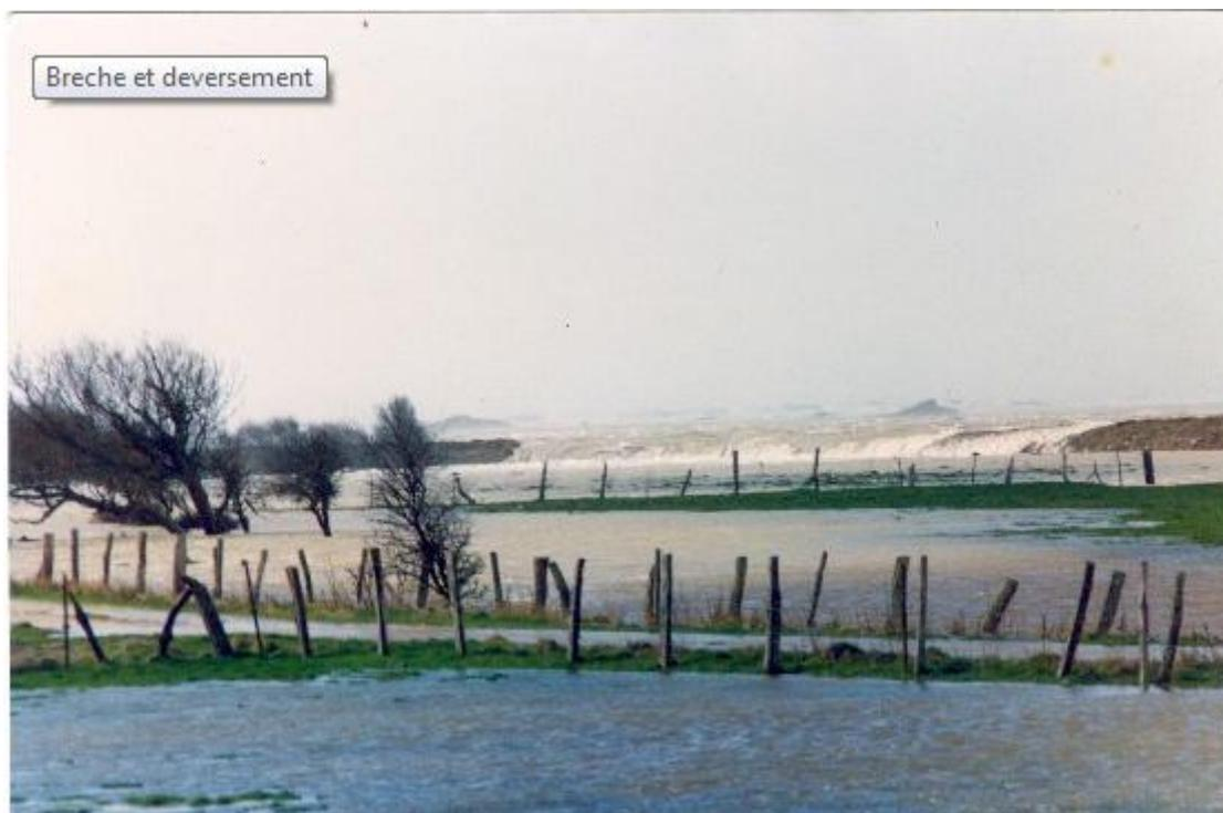
Figure 22 : Photographie d'une brèche sur le cordon de galet de Cayeux lors de l'épisode de submersion de 1990. Source : Cayeux-citoyens
