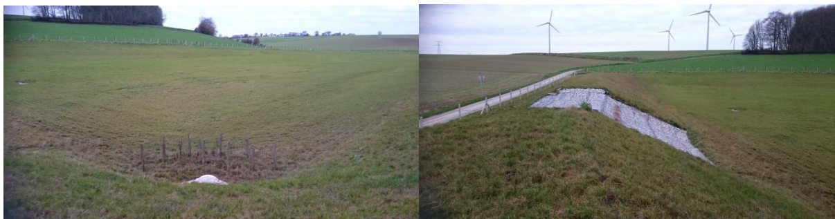
Figure 74 : Retenue collinaire de Coupelle-Vieille (CC du Haut Pays du Montreuillois)
