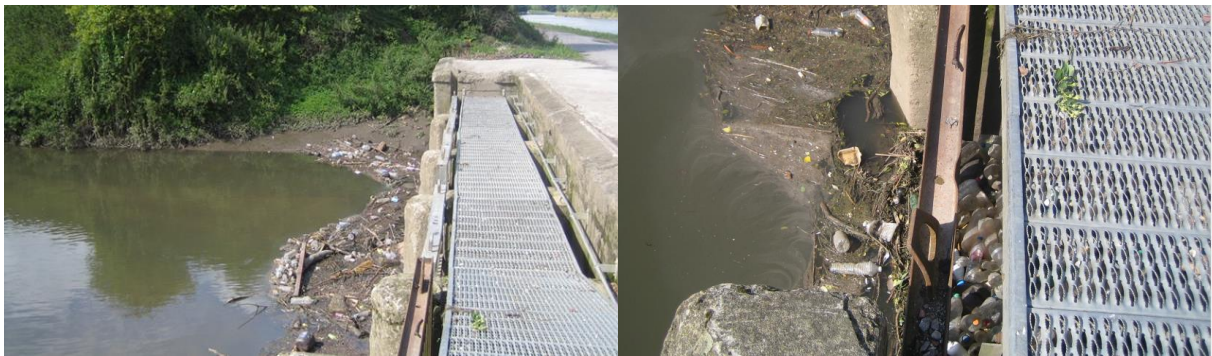
Figure 56 : Accumulation de déchets aquatiques au siphon de la Lawe à Béthune (EPTB Lys)
