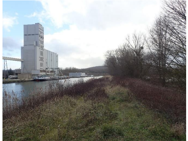
Vue depuis la crête de la digue en janvier 2020 (à gauche, le bief de navigation, à droite (cachée par les arbres) s'écoule la Meuse)
