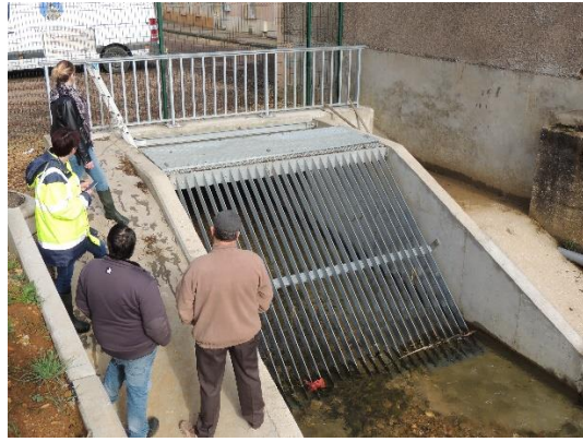
Entrée du dalot (après travaux)
