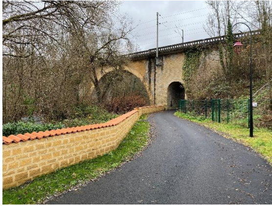
Protections localisés (type « mur de protection ») sur le site de Cons-la-Granville aval
