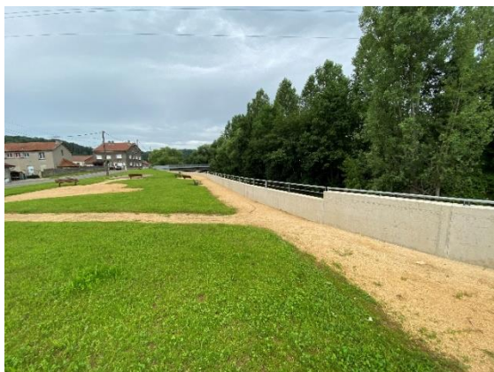
Protections localisés (type « mur de protection ») sur le site de Charency-Vezin)
