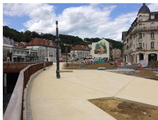
Réhabilitation de l'espace public à l'été 2019
