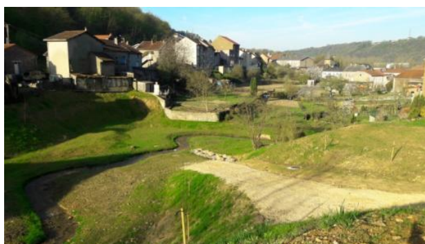
Secteur de renaturation (après travaux)
