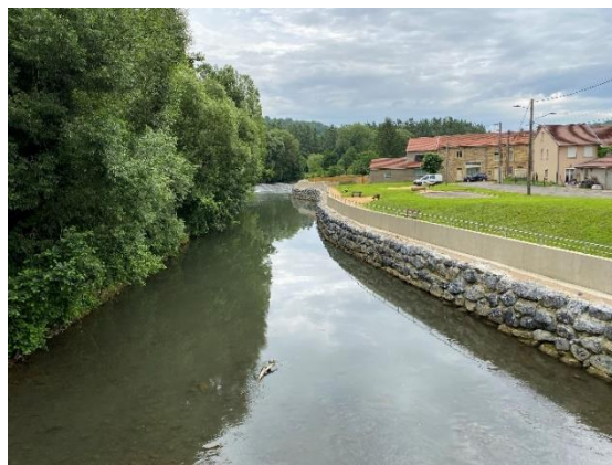
Protections localisés (type « mur de protection ») sur le site de Charency-Vezin)
