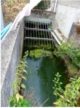
Entrée du dalot (avant travaux)
