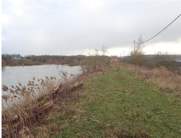
Vue depuis la crête de la digue en janvier 2020 (à gauche, la Meuse, à droite (invisible sur l'image) le bief de navigation)
