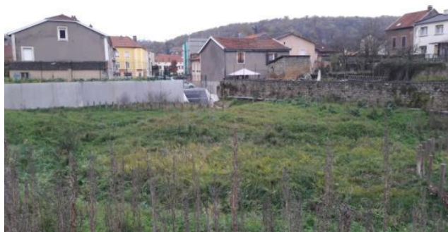
Secteur du piège à embâcle (après travaux)
