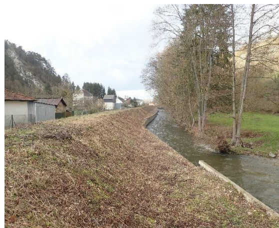
Vue de la digue sur son tronçon médian côté Houille (janvier 2020)
