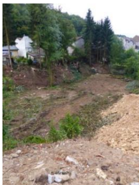
Secteur de renaturation (pendant travaux)
