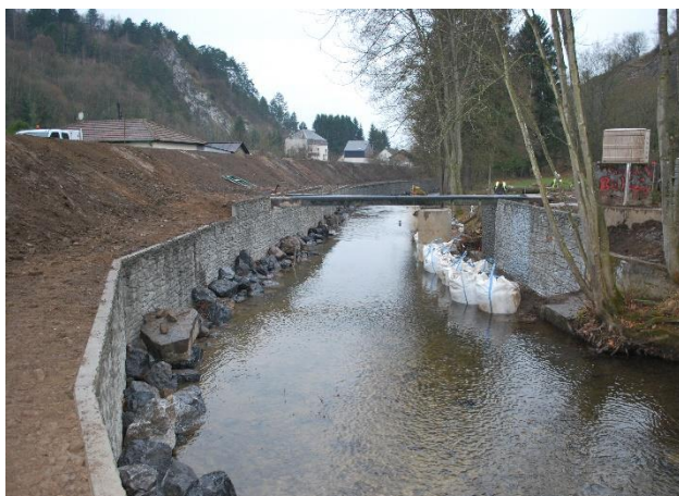
Première phase de travaux sur le tronçon le plus dégradé (décembre 2016)
