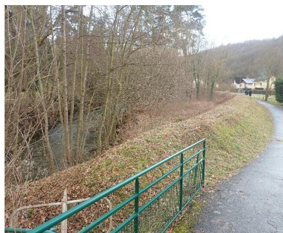
Vue de la digue sur la partie la plus en aval du tronçon médian (janvier 2020)
