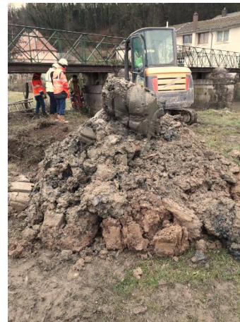
Sondage des piles de la passerelle d'Harchéchamp (site VAI04) fin 2021
