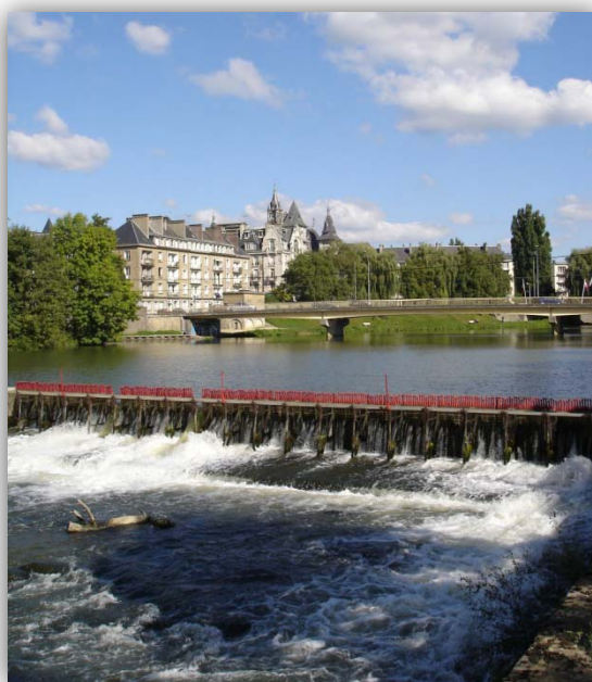
Photo 5 : Vue aval du barrage à aiguilles de Mézières (EPAMA- EPTB Meuse, 2007)
