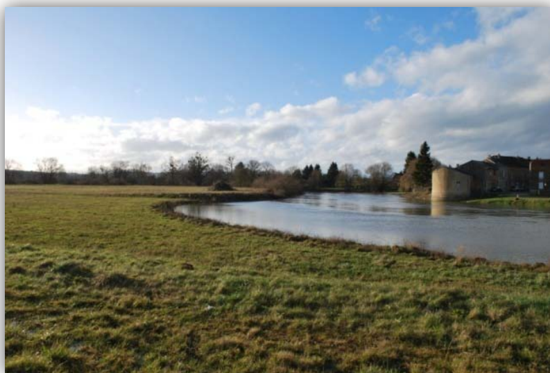
Photo 32 : Vue aval de la coupure sèche de Warcq (EPAMA- EPTB MEUSE, 2014)
