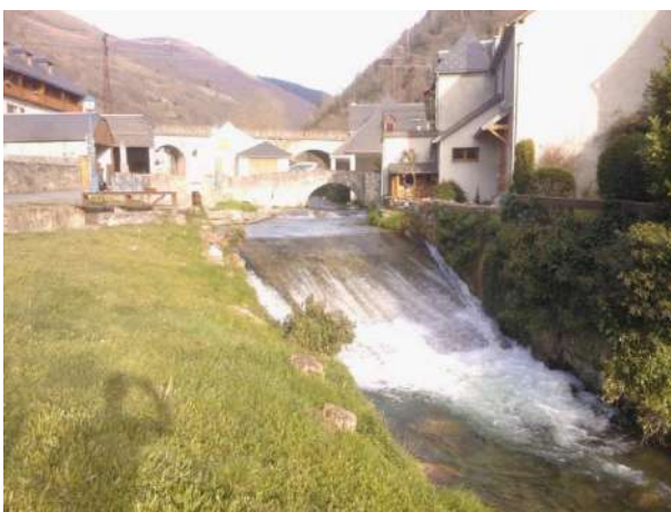
Vue du seuil depuis l'aval
