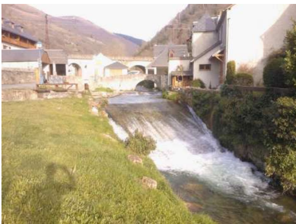
Vue du seuil depuis l'aval
