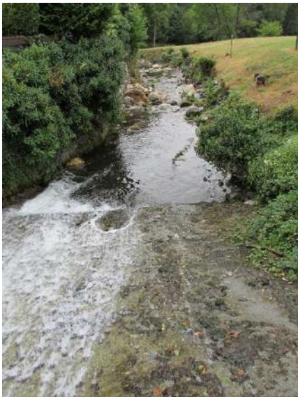
Vue vers l'aval depuis le seuil
