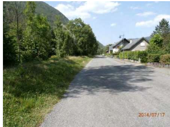
Digue de protection du lotissement Bernet à Vielle-Aure - PK 48.8 – Tronçon 3
