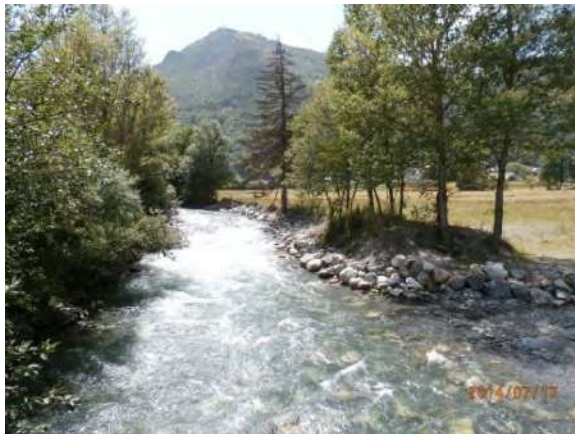
Digue de protection de terres agricoles à Vignec PK 50.6 – Tronçon 3
