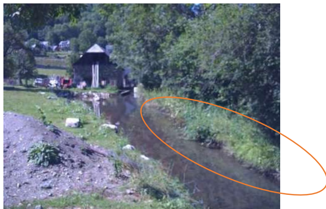
Digue de canal à Avajan – Neste du Louron PK 49.6 – Tronçon 5
