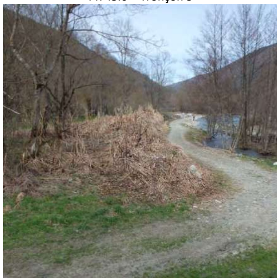
Digue rive gauche à Vielle-Louron – Neste du Louron - PK 51– Tronçon 5
