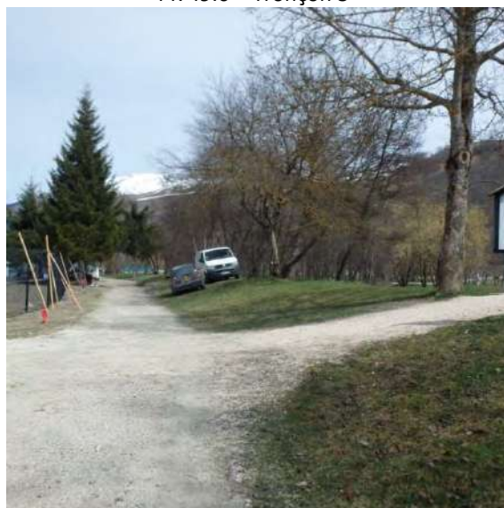
Digue à Génos – Neste du Louron PK 55.22 – Tronçon 5
