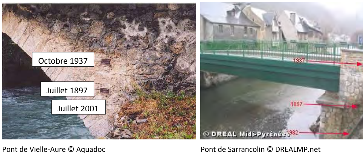
Fig. 28. Repères de crues positionnés sur des ponts
