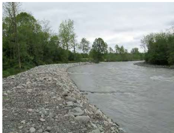
Digue de galets réalisée en post-crue 2013 - Bizous
