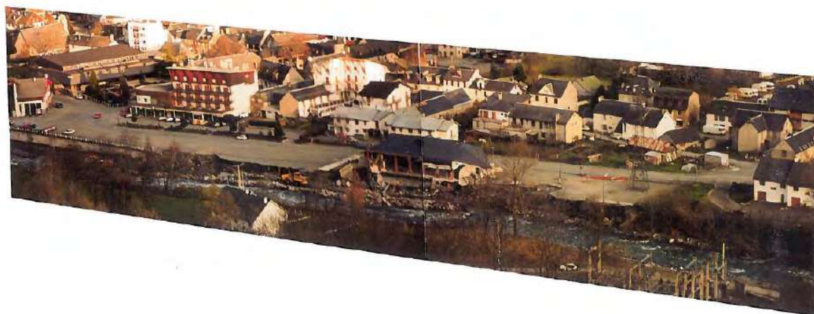
Fig. 31. Dégâts occasionnés par la crue de 1982 sur la rive droite de Saint-Lary
