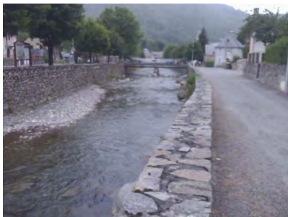
Digue à Bordères-Louron – Neste du Louron PK 45.6 – Tronçon 5
