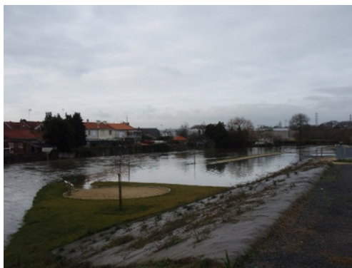
Illustration 9 - Travaux de réouverture du lit majeur sur la Moine, à Cholet (49)
