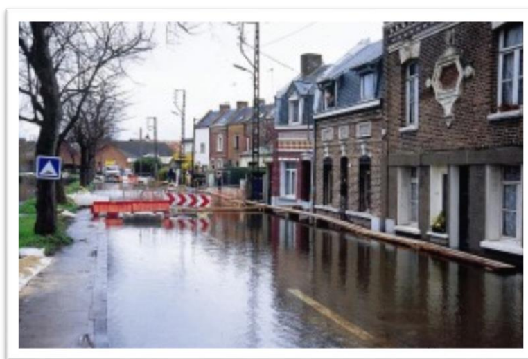
Photographie 5 : Rue de Verdun inondée à Amiens (source : E. Therouin)
