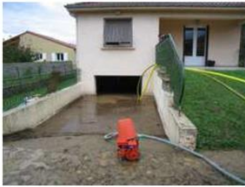
Garage inondé en bordure de la RD 630
