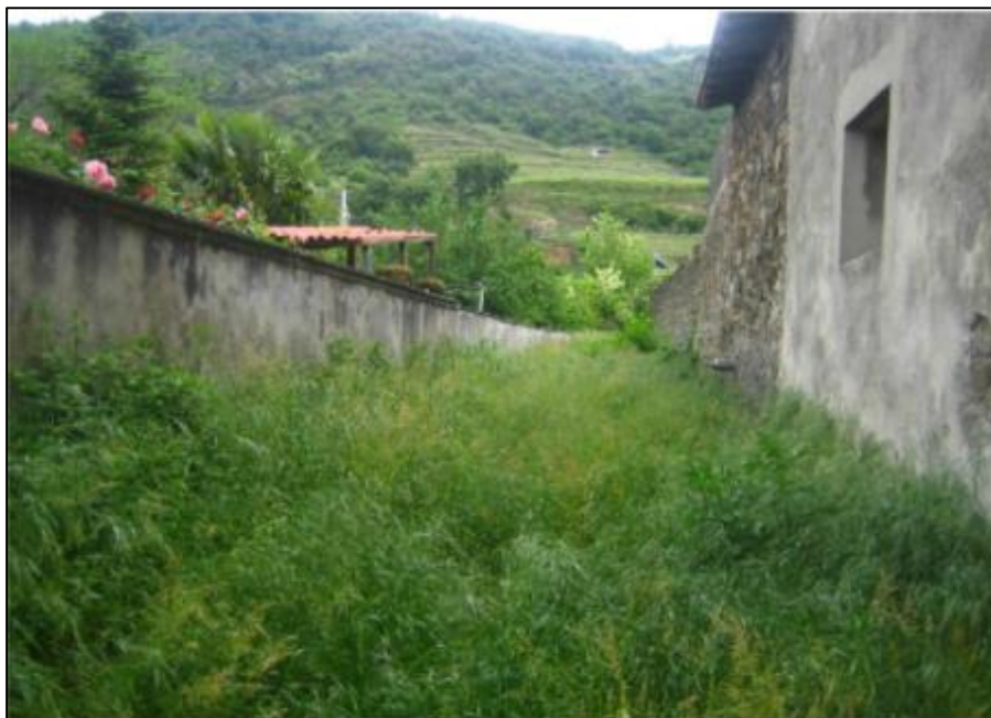
Figure 49 : Dignes du Ruisseau des Barres en amont de la N7 ( PPRI Serves sur Rhône)
