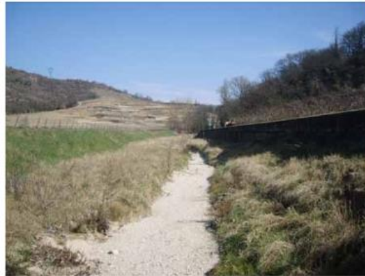
Figure 54 : Le ruisseau de Crozes à l'amont du pont SNCF (PPRI Gervans)
