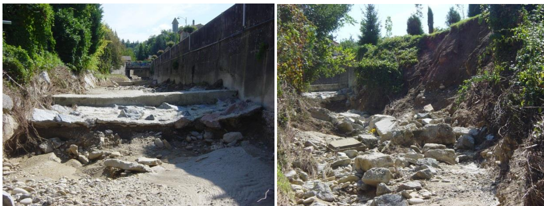
Figure 59: Ruisseau Le Crozes après la cruée de 2008 ( Arche Agglo )
