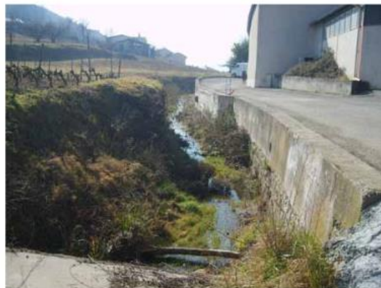
Figure 53 : Le Gervans à l'entrée du village de Gervans ( PPRI Gervans )
