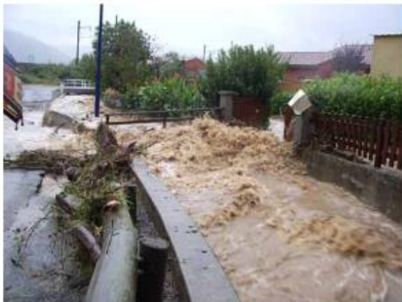
Passerelle submergée par le Gervans chenalisé
