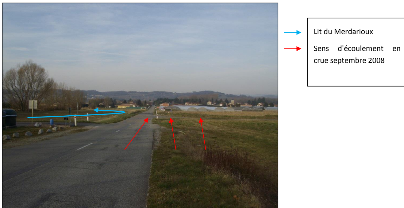
Figure 9 : Passage du Merdarioux sous la RD115 en entrée Est de la commune de Chavannes (Source Hydrétudes – MOE des travaux de limitation des crues du Merdarioux)
