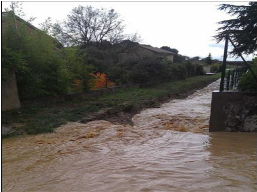
Figure 6 : Le Merdarioux à Marsaz avant et pendant la crue du 23 octobre 2013 au franchissement de la rue des Cottines ( Source Arche Agglo)
