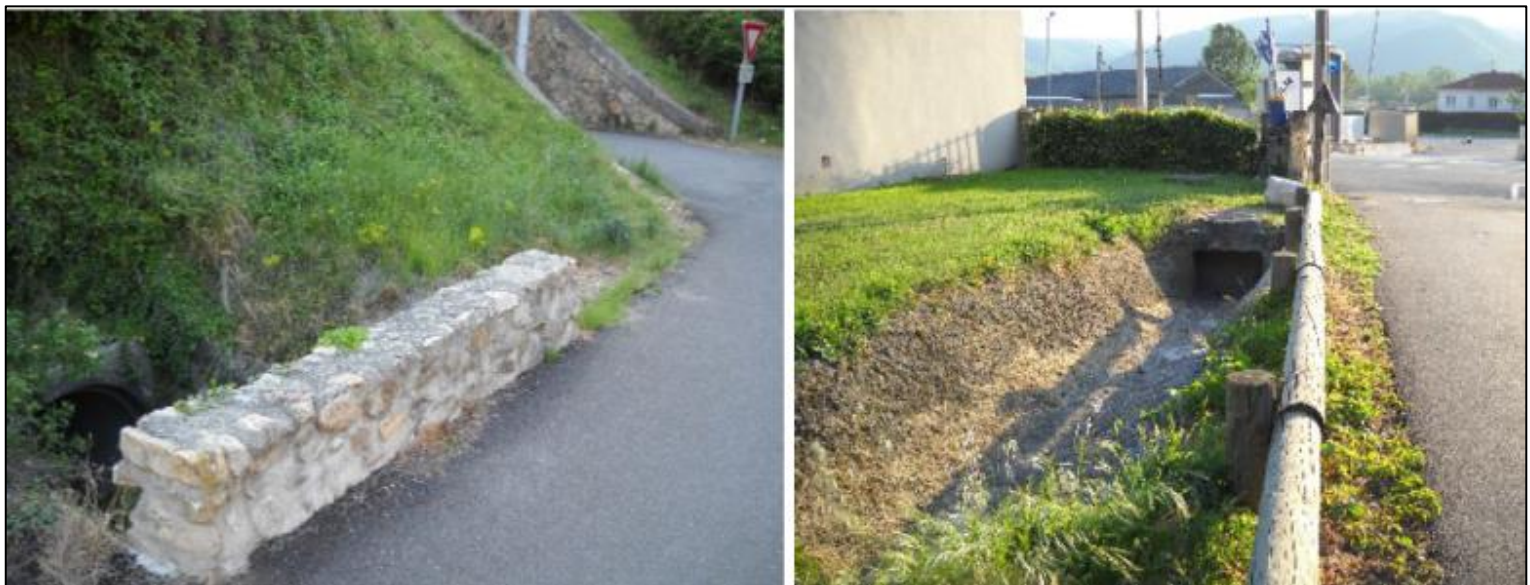
Figure 51 : Franchissement de la voie SNCF (gauche) et franchissement de la RN7 par le ruisseau des Marais et des Coffins( PPRI Servès sur Rhône)
