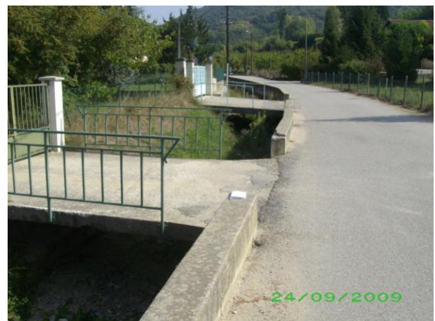
Les passerelles OH4 et OH5
