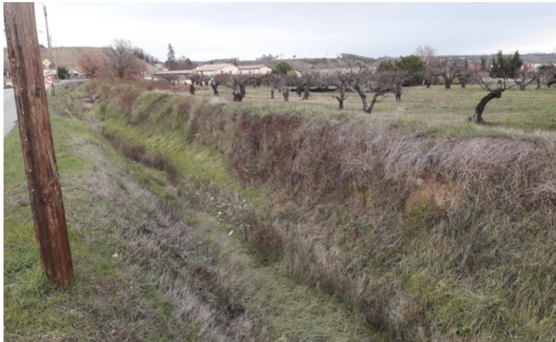
Digue du Colombier, 2017, Arche Agglo
