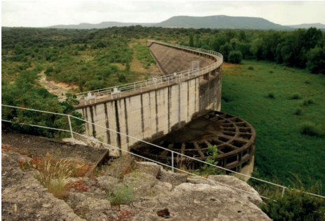
Le barrage de Ceyrac en amont
