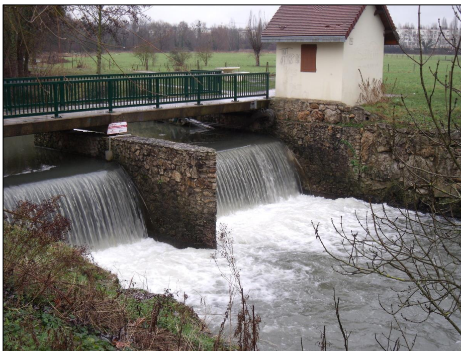
Figure 1 : Barrage régulateur de la Plaine de Chalandray
