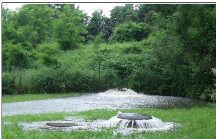
Figure 58 : Exutoire de délestage du lac Montalbot
