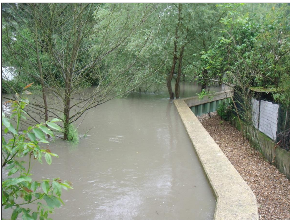
Figure 4 : Ouvrage de protection local digue du Gord (le 2 juin 2016)
