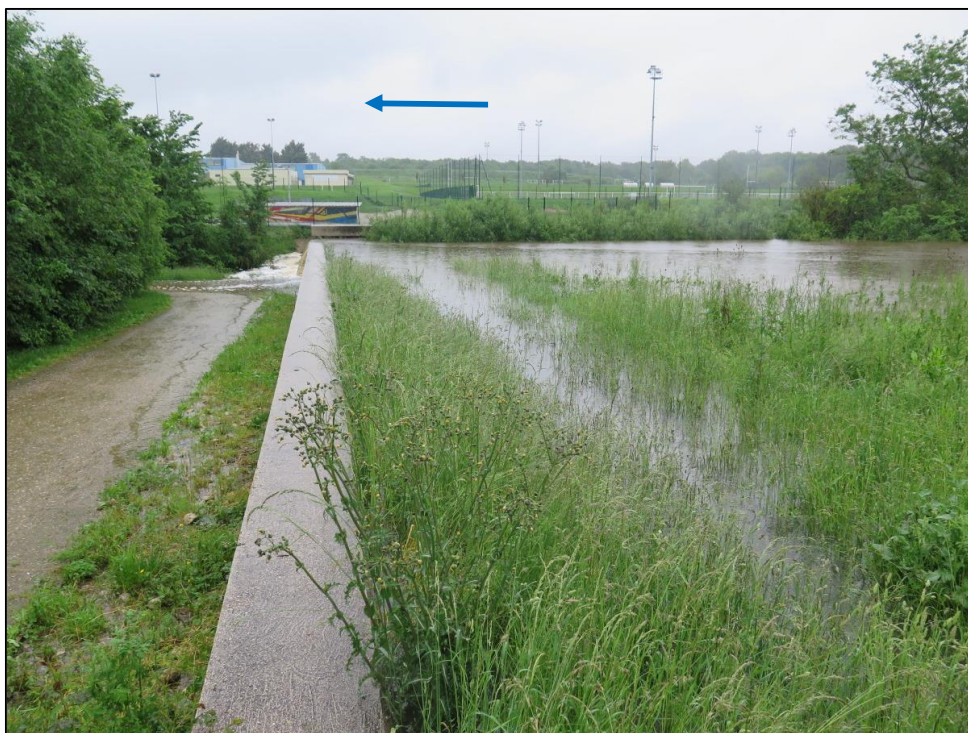
Figure 5 : ouvrage de protection local du ru d'Oly
